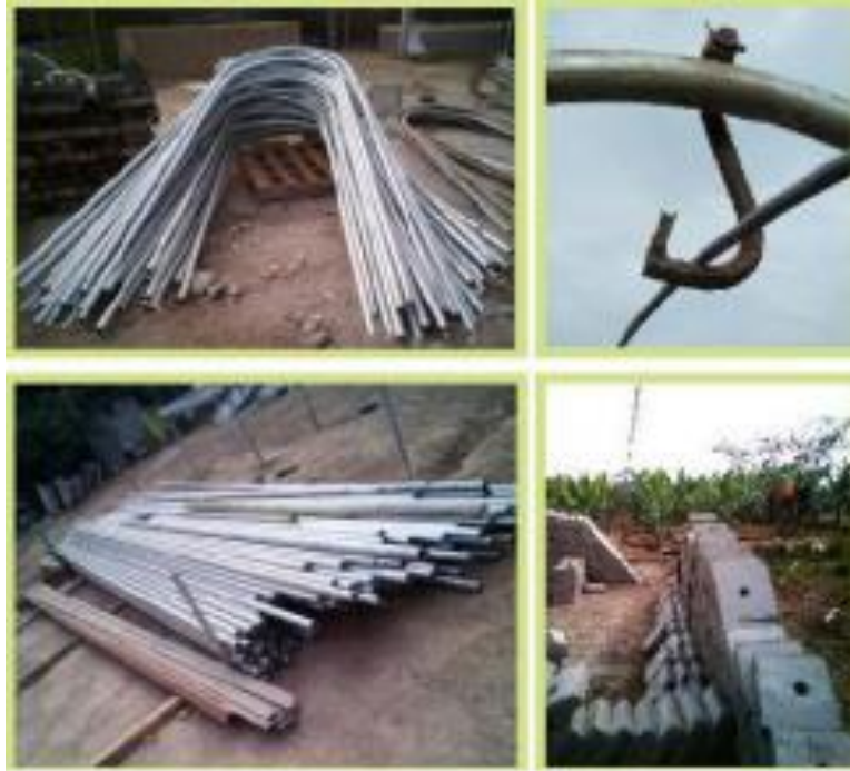
Ilustración 3.- Detalles del Cable Vía. Zetas Torres. Galletas
