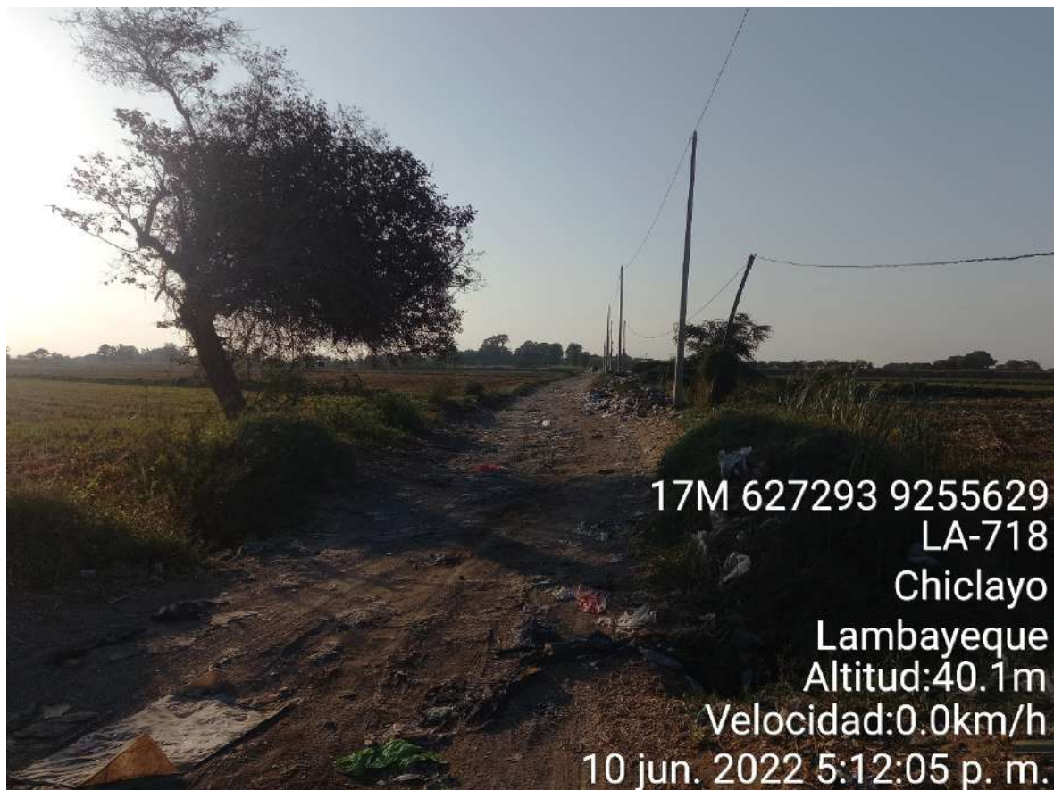
Figura 18. Estado actual de la vía trocha carrozable
