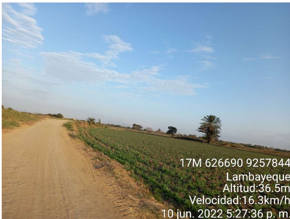
Figura 21. Estado actual de la vía trocha carrozable
