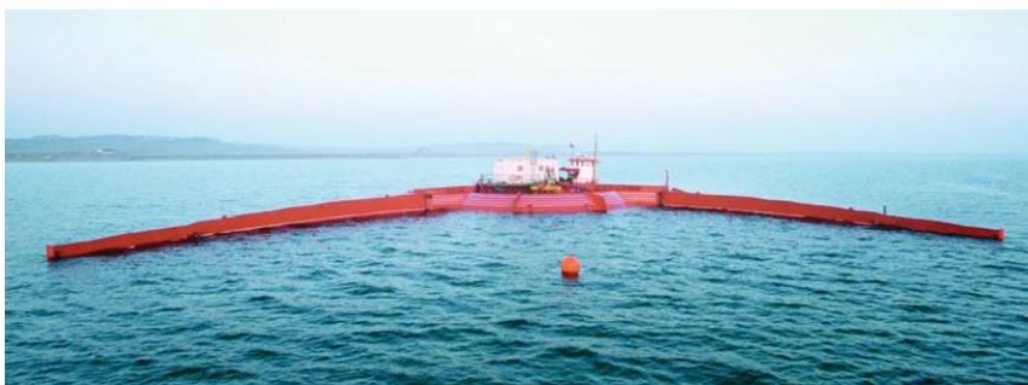
Figura 16. Generador Wave Dragon, Rango 11 MW.
