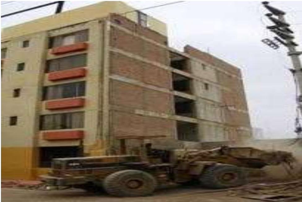
FIGURA 10. Uso de Muros de Hormigón Armado
