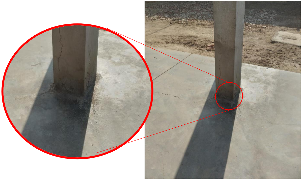
Figura. Asentamiento de columna y debilitamiento del recubrimiento
