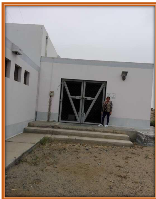
Fig23. Visitando la Planta de Tratamiento De Agua Potable.
