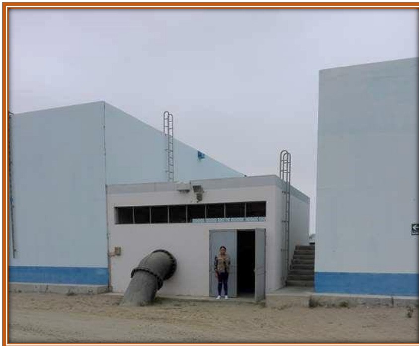
Fig22. Visitando la Planta de Tratamiento De Agua Potable.
