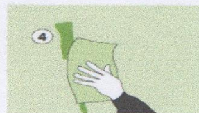
4 Aplicación de masilla elástica
