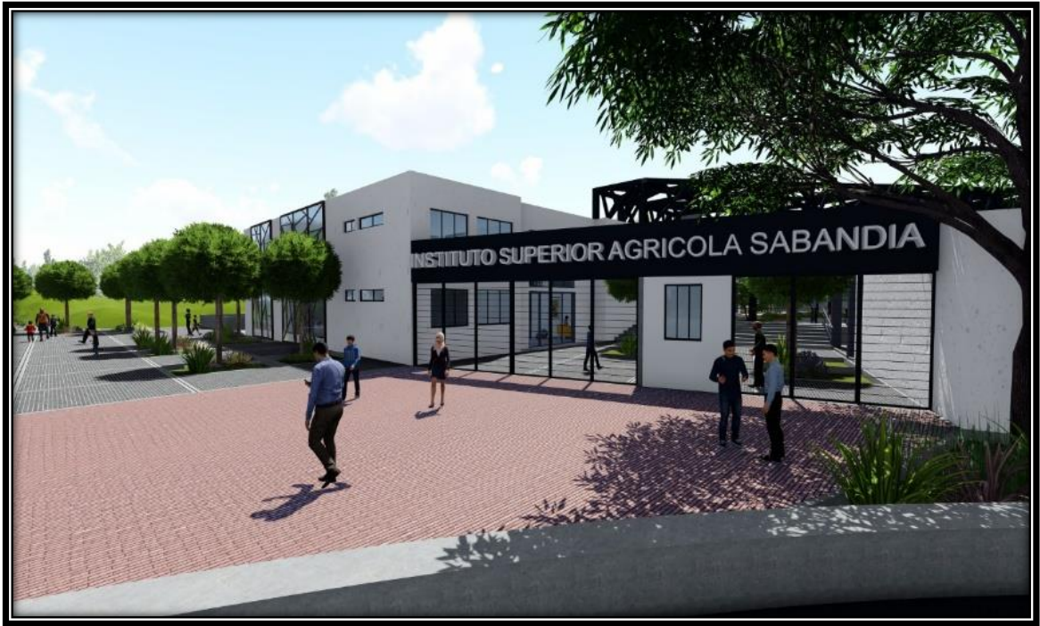
Figura 38. Vista: Exteriores del Proyecto (10) Ingreso Principal
