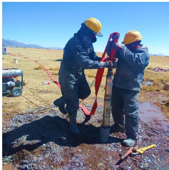
Figura 17. Prueba de bombeo succión
