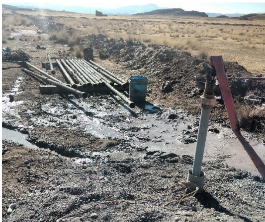
Fotografía 05: Prueba de carga y abatimiento del pozo.
