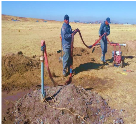
Figura 16. Prueba de bombeo en la línea de impulsión
