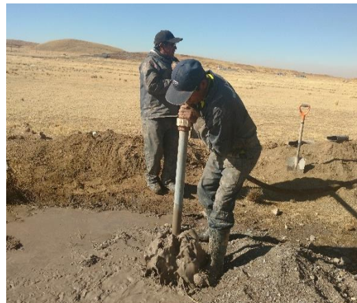
Fotografía 06: desarrollo y rendimiento del pozo.
