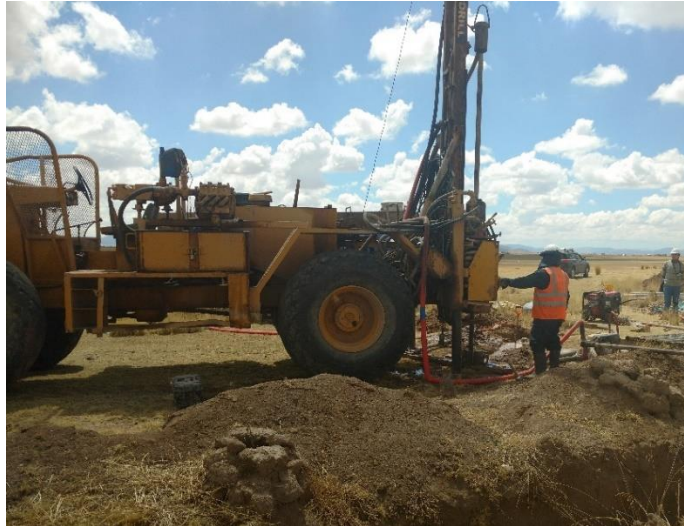
Figura 14. Prueba de carga y abatimiento de pozo explorado.
