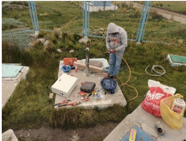
Figura 20. Instalación del sistema fotovoltaico
