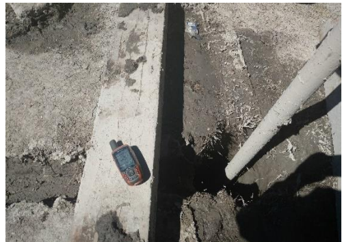
Fotografía 04: Ubicación exacta de coordenadas del pozo explorado
