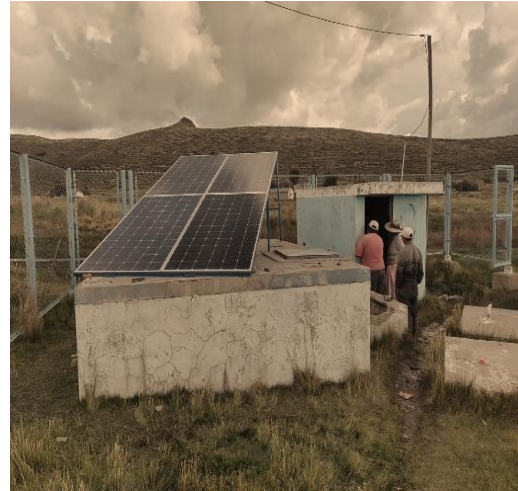
Fotografía 08: Prueba y dimensionamiento de paneles solares.
