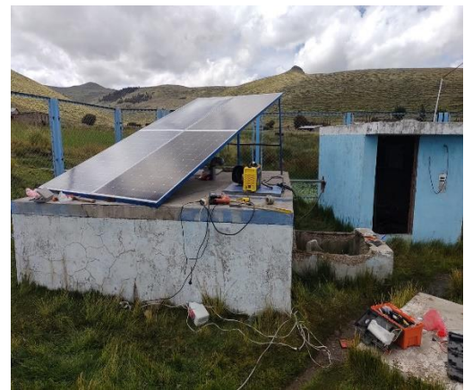
Fotografía 10: Prueba y funcionamiento del sistema fotovoltaico
