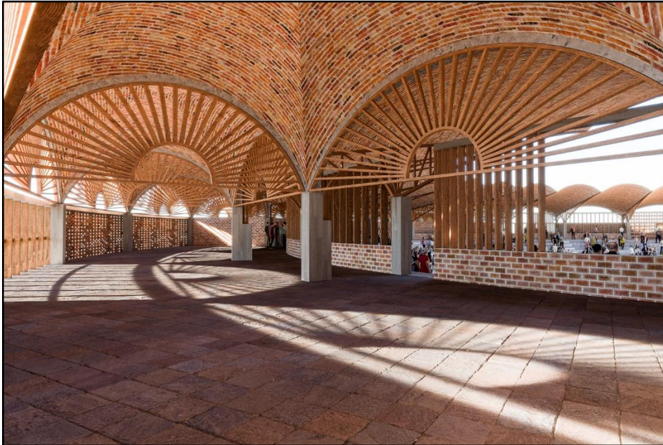
Figura 27 Pasillo interior de Parque cultural
