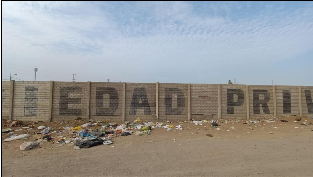
Figura 82 Imagen de vía auxiliar en abandono.
