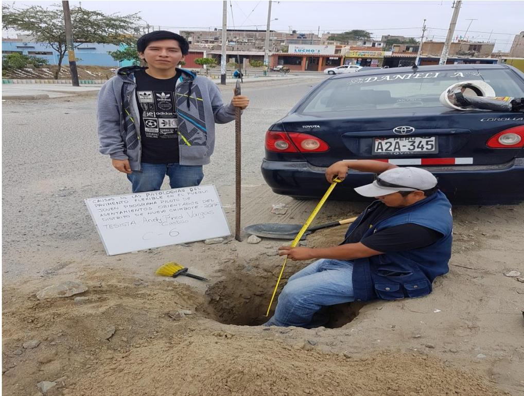
Foto 13: Se procedió a medir la altura de la calicata y las capas que forman el pavimento.
