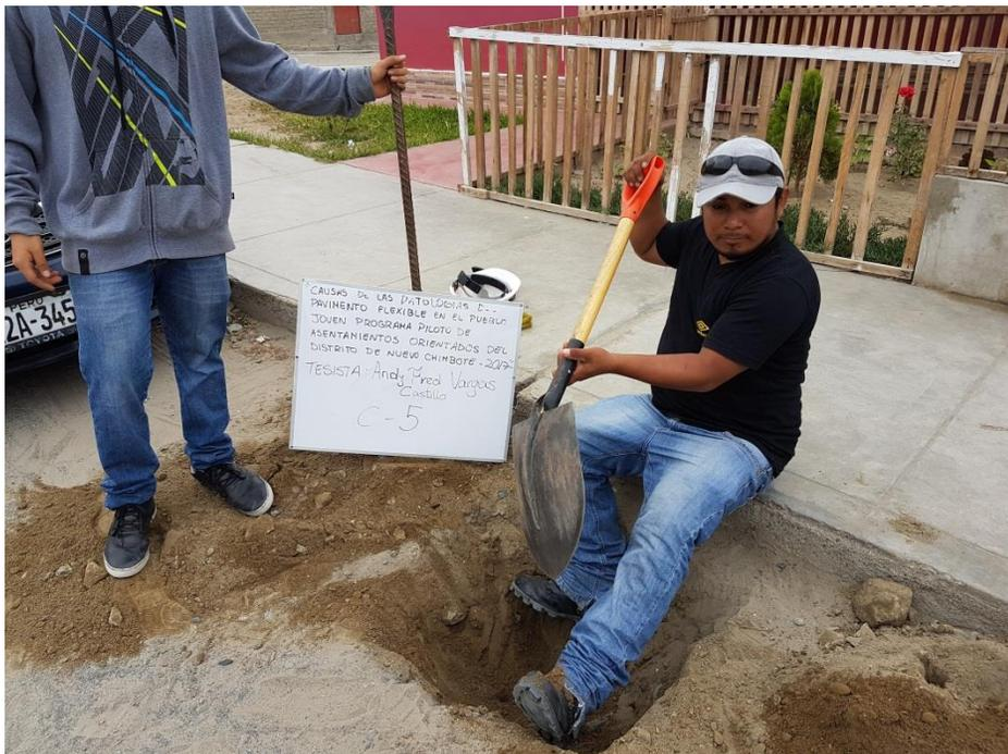
Foto 10: Se procede a excavar la calicata de la progresiva 1+000
