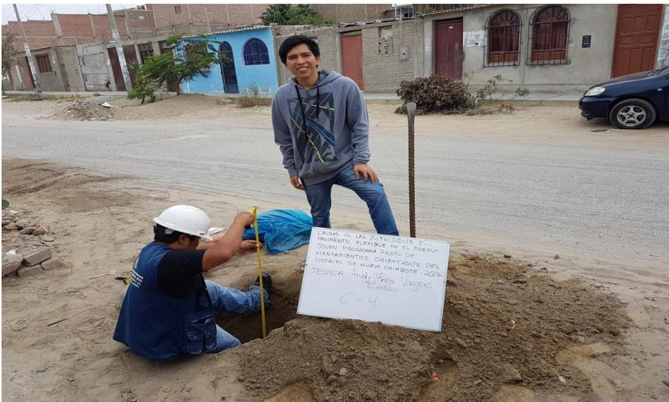
Foto 8: Excavación de la calicata de la progresiva 0+800
