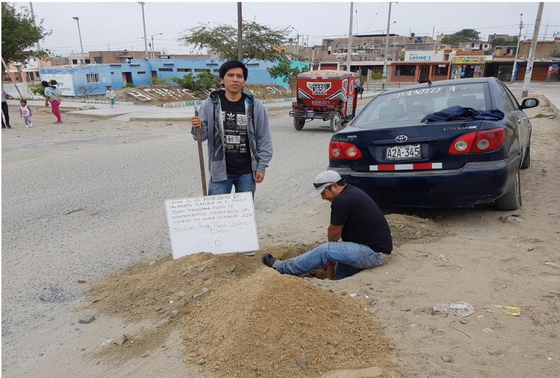
Foto 12: Excavación de la calicata de la progresiva 1+200
