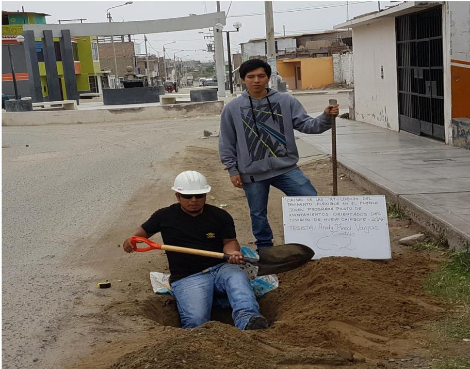
**Fotos 3:** Excavación de calicatas en la progresiva 0+400
