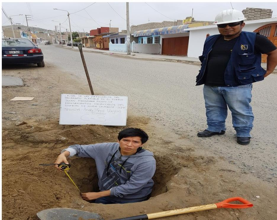
Foto 6: Se procedió a medir las capas que forman el pavimento
