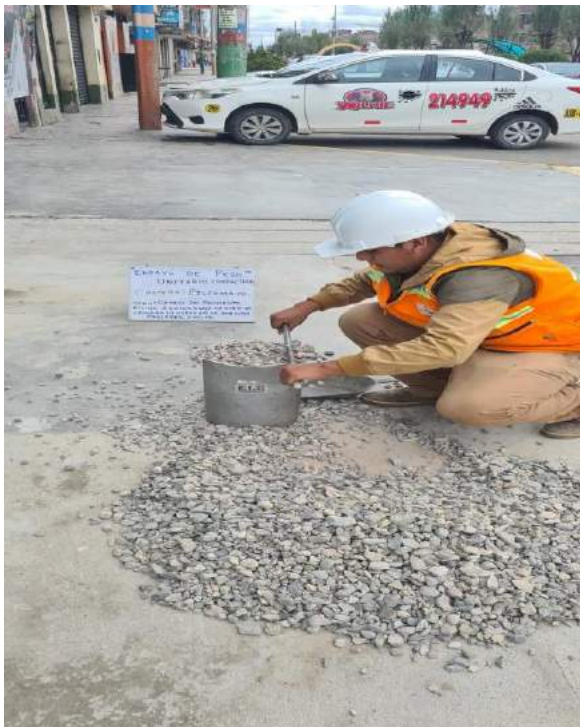
enrasado de la piedra compactada
