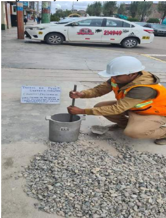
compactado de la primera capa
