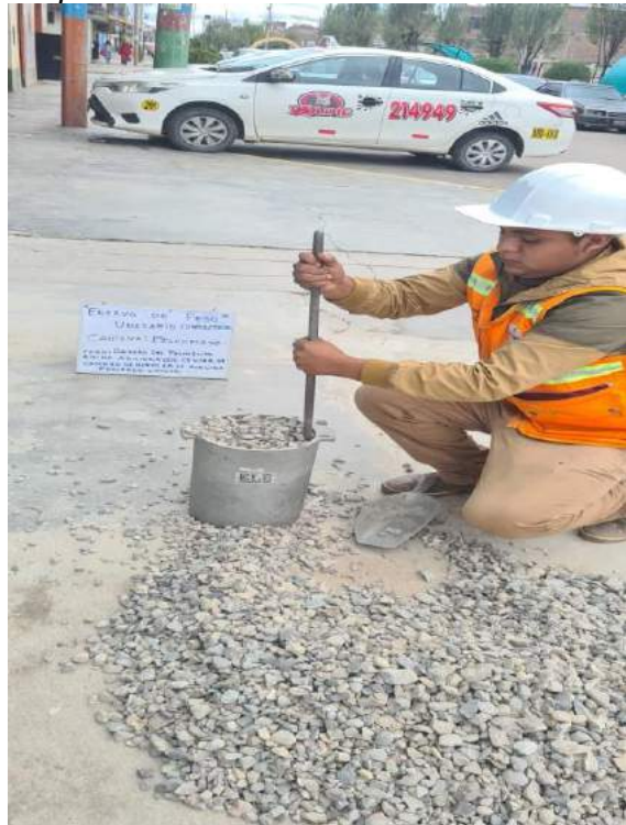
compactado de la tercera capa
