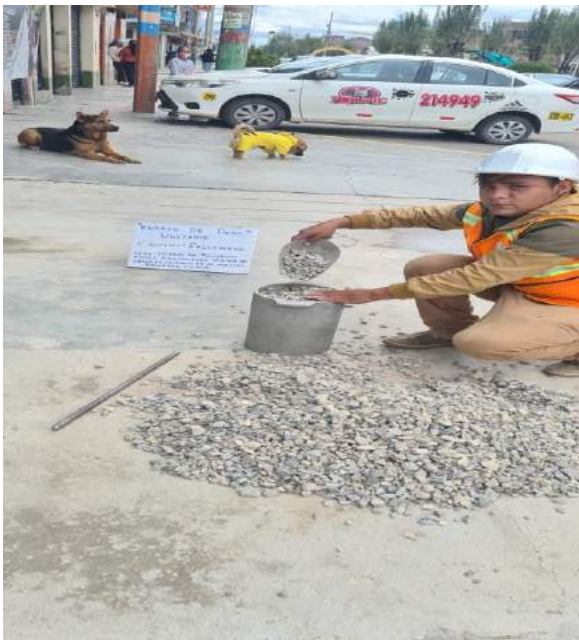
terminado de llenado de la piedra.
