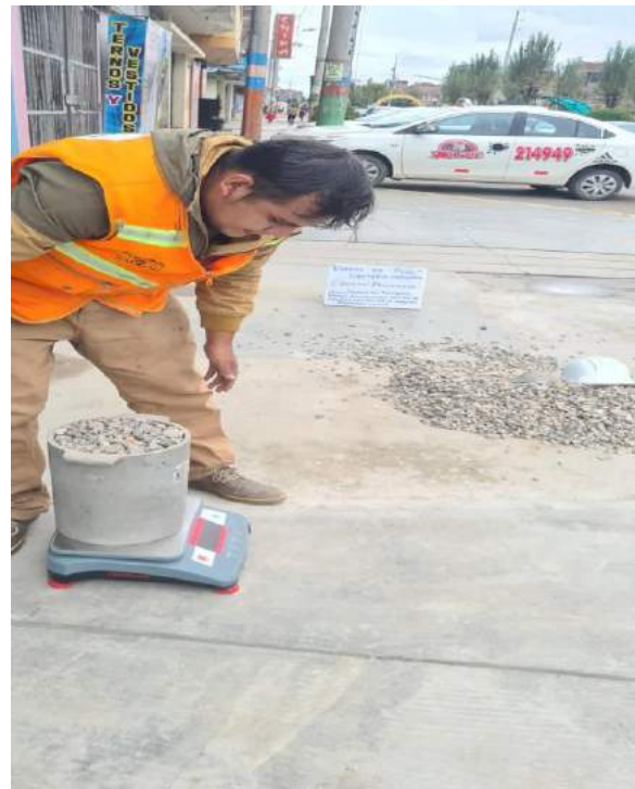
pesado de la piedra compactada
