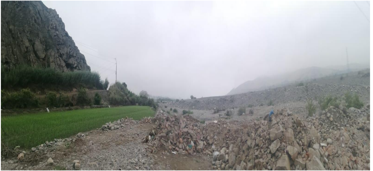
Figura 17: Escombros acumulado que alterar el cauce del río
