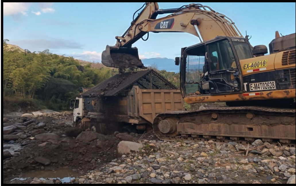
Figura 77. Excavadora S/Oruga CAT 336 DL
