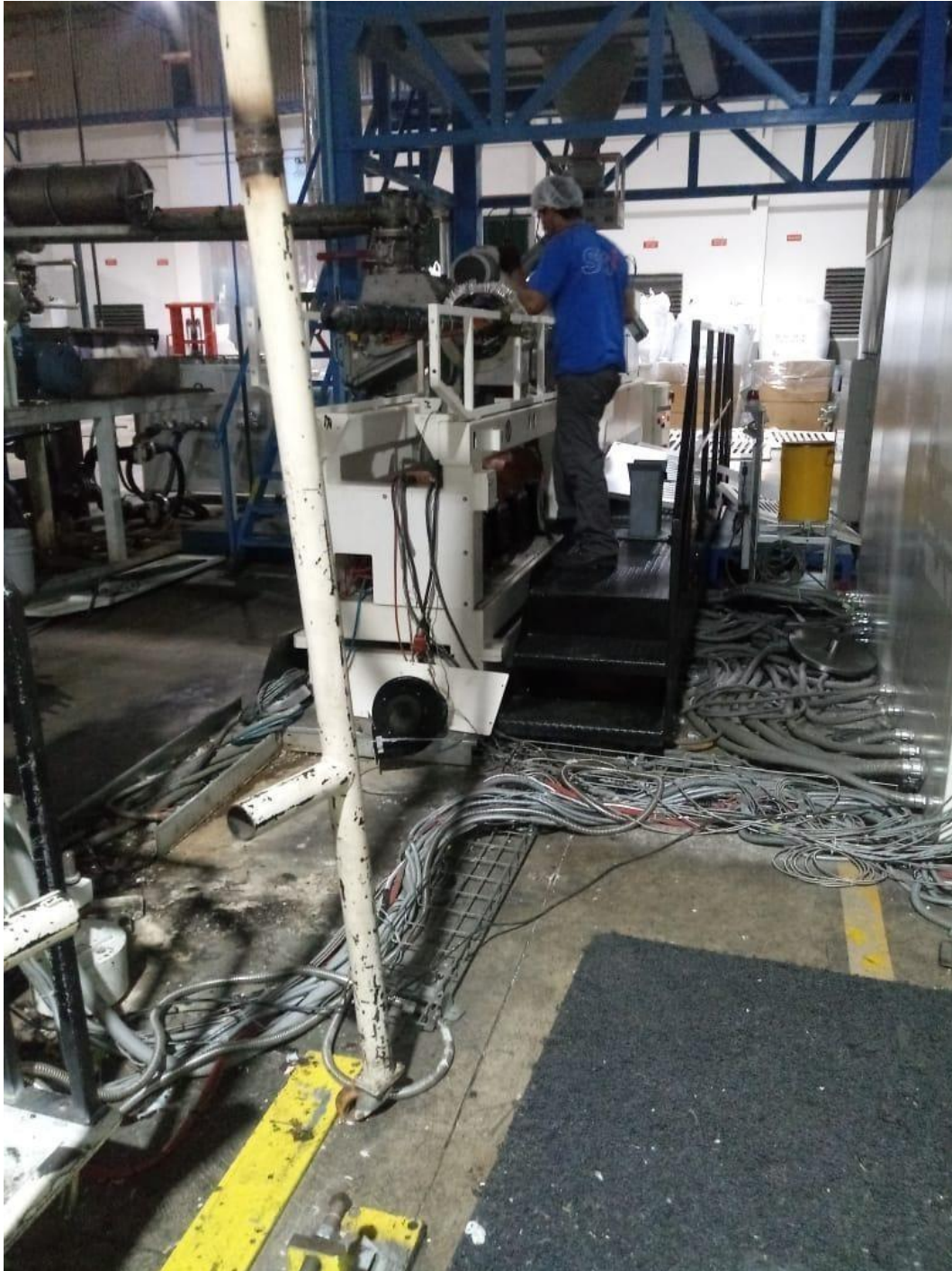
Figura 46: Inspección y limpieza
