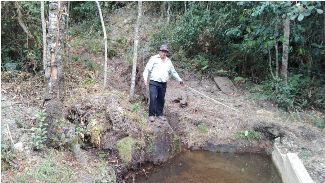
Sistema de saneamiento básico rural en la localidad de Pueblo Viejo, Yauyucan-Cajamarca – toma de agua lateral, 2022.
