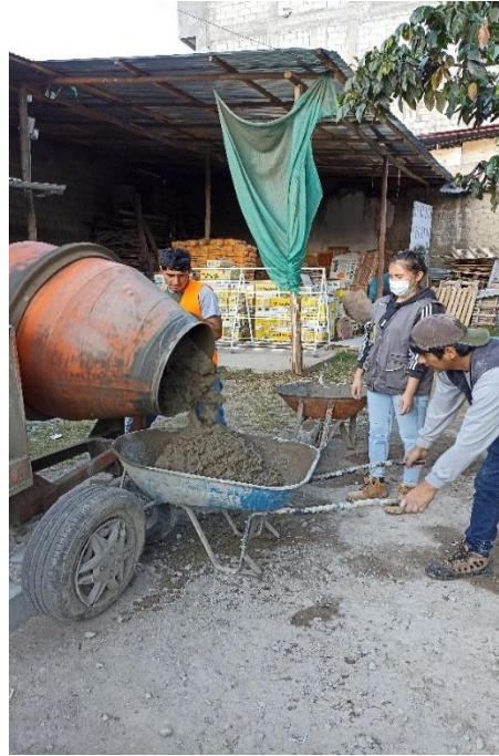
Fotografía 7: Preparación de la mezcla de concreto patrón y experimental.
