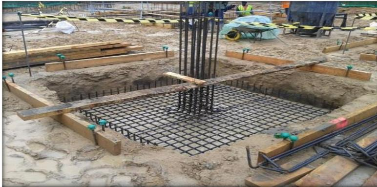
Figura 7: Zapata Aislada
