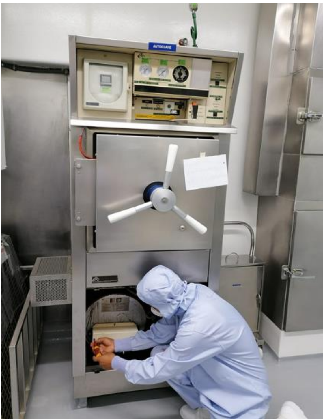
Figura 32. Técnico realizando el mantenimiento Preventivo
