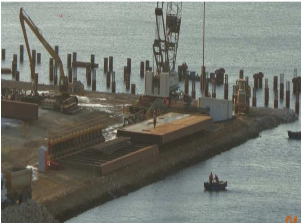
Fig. 09 - Vista panorámica de pre armado en tierra
