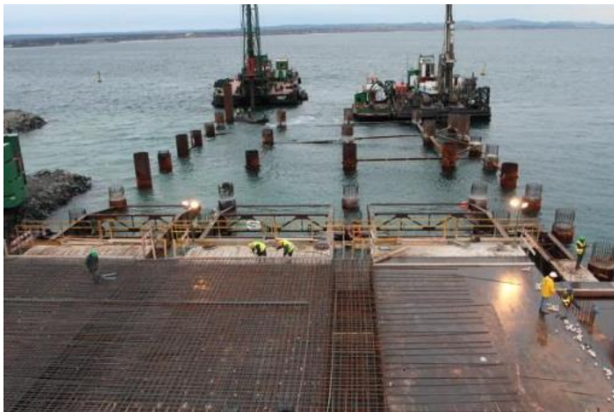
Fig. 15 - Mesas interiores de cimbra
