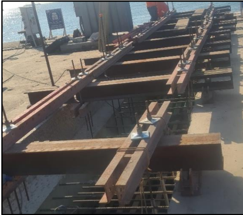
Fig. 27.4 – Instalación de vigas primarias transversales
