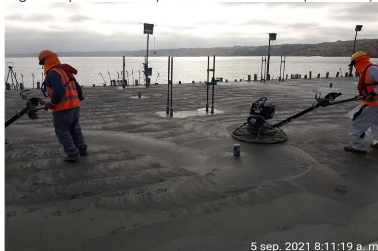
Figura 8 pulido de superficie de concreto (acabado)
