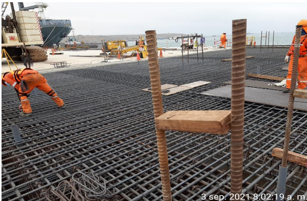
Figura 4 Colocación de Acero en cimbra o encofrado metálico
