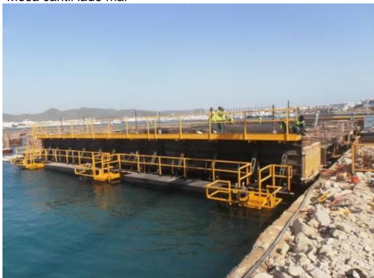
Fig. 19 - Vista cantil lado mar
