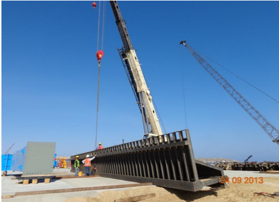
Fig. 08 - Pre armado en tierra
