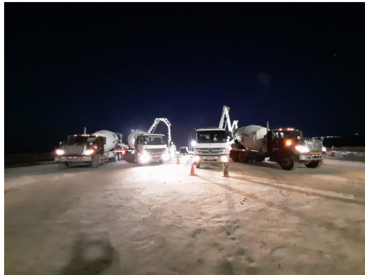
Figura 7 Ubicación de 2 mixers por bomba para despacho masivo
