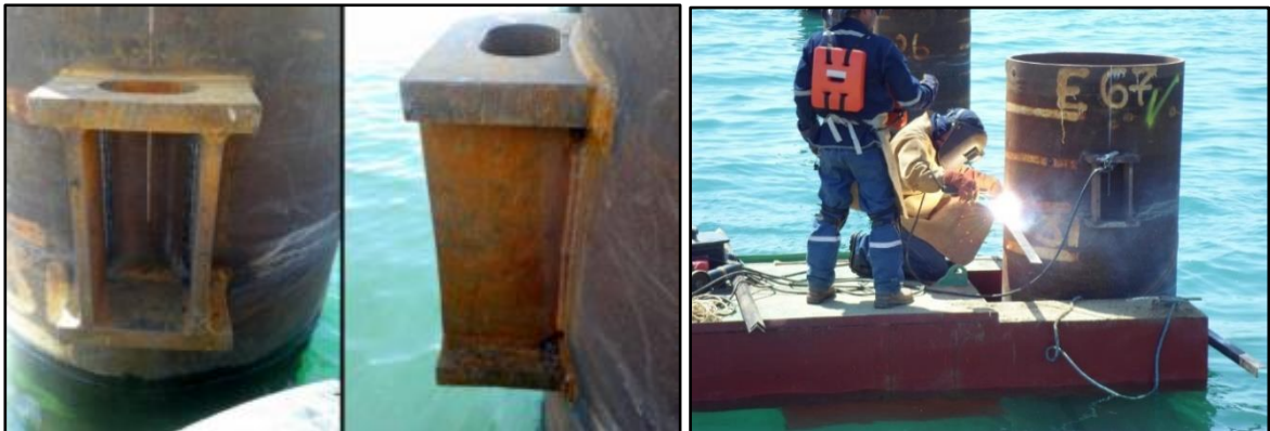
Fig. 07 - Colocación de ménsulas en los pilotes
