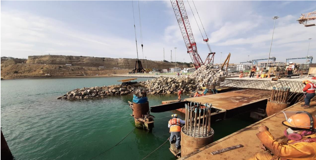
Figura 3 Vista Lateral de encofrado de Tramo 15 tablero de muelle
