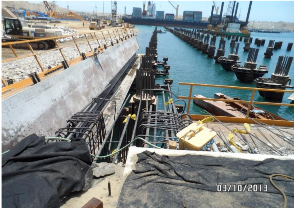
Fig. 43 - Avance cantil lado tierra
