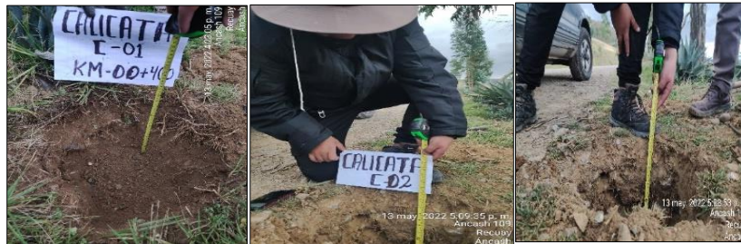
Figura 9: Ubicación de calicatas
