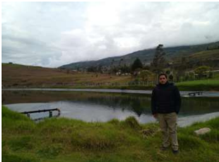
Figura 2: Visita a la PTAR de la provincia de Celendín
