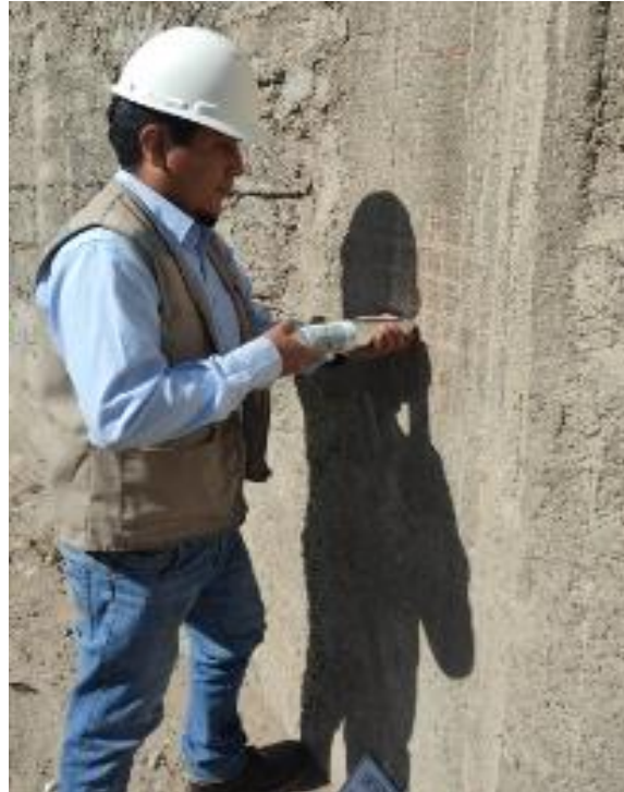
Figura 35. Ensayo de resistencia del concreto seco con esclerómetro.
