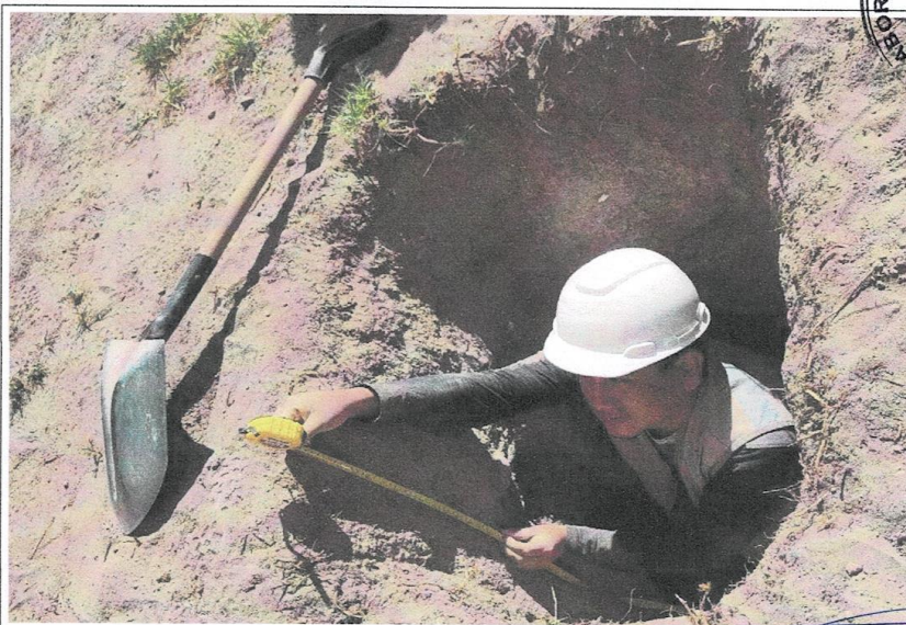
CALICATA 01- FOTO 02, PANORAMICO.
