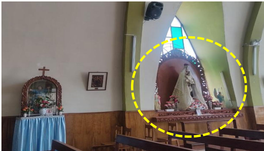
Figura 22. Elementos no estructurales en la nave lateral
