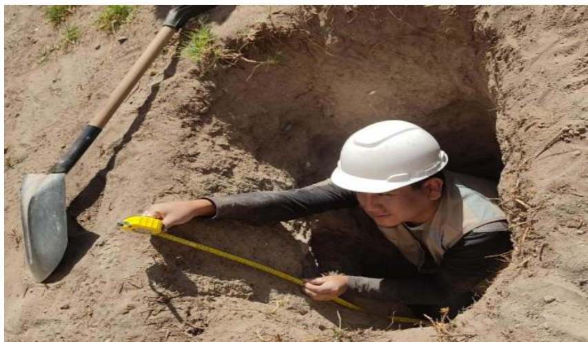
Figura 9. Realización de la calicata C1.
