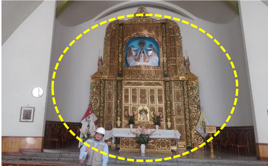
Figura 21. Elementos no estructurales en el ábside
