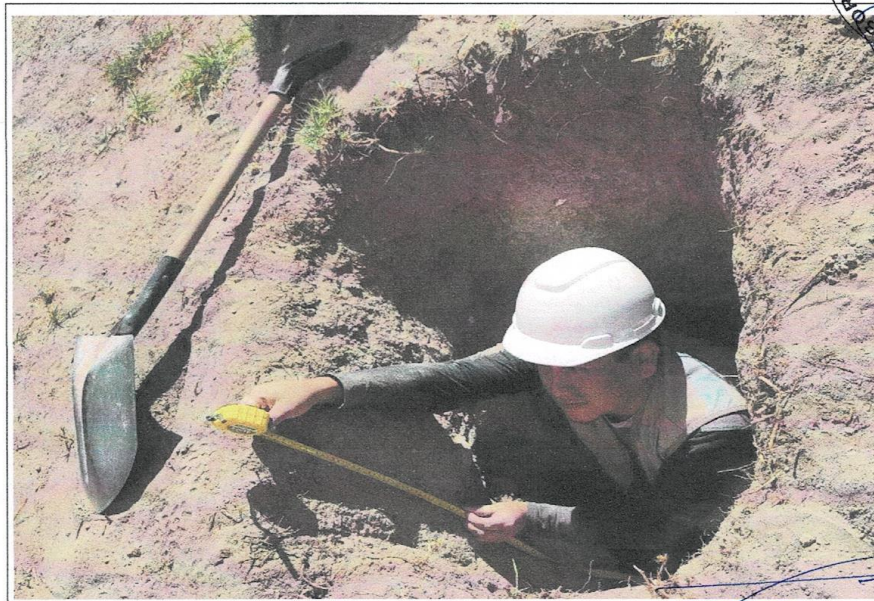
CALICATA 03- FOTO 06, PANORAMICO.
