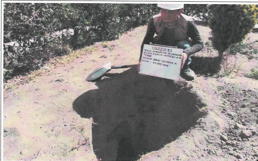
CALICATA 01- FOTO 01, DETALLE
