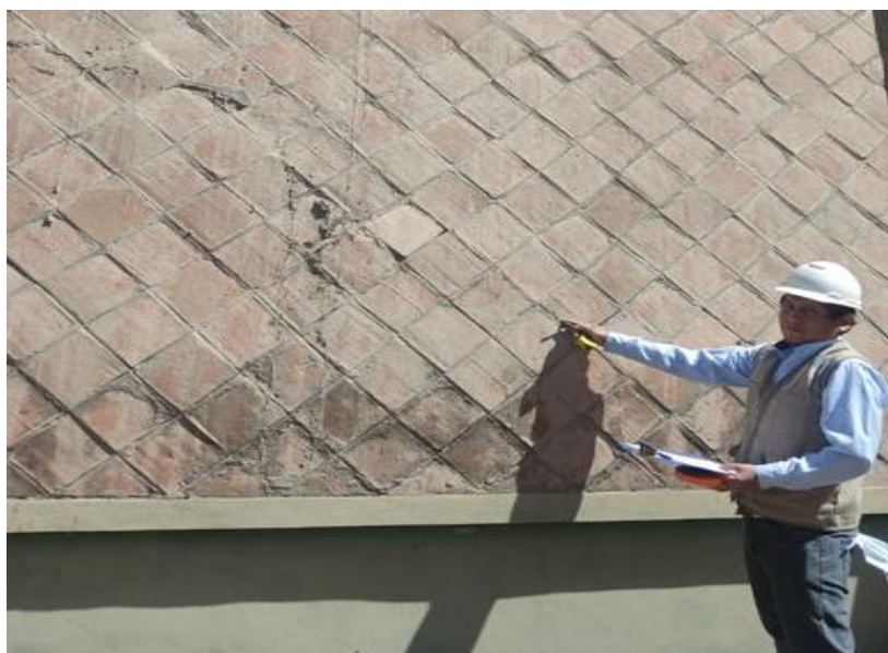
Figura 36. Inspección de la estructura evaluada
