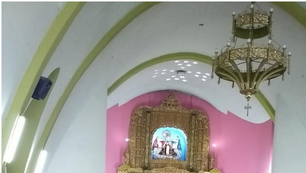
Figura 16. Detalle de bóveda de la Parroquia Santísima Trinidad de Tingo
