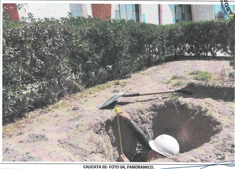
CALICATA 02- FOTO 04, PANORAMICO.
