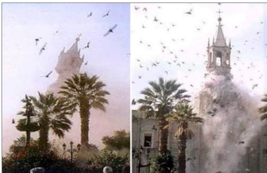
Figura 4. Desplome de la torre de la Catedral de Arequipa.
