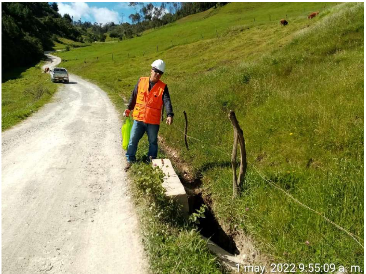
Figura N°1: Alcantarilla existente. Fuente: Fotos tomadas por los tesistas
