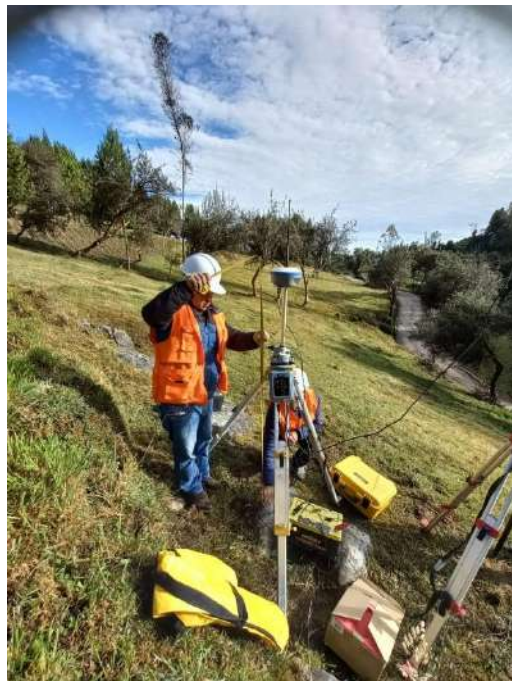
Figura 5: Ubicación del GPS diferencial para posteriormente realizar la toma de puntos.
