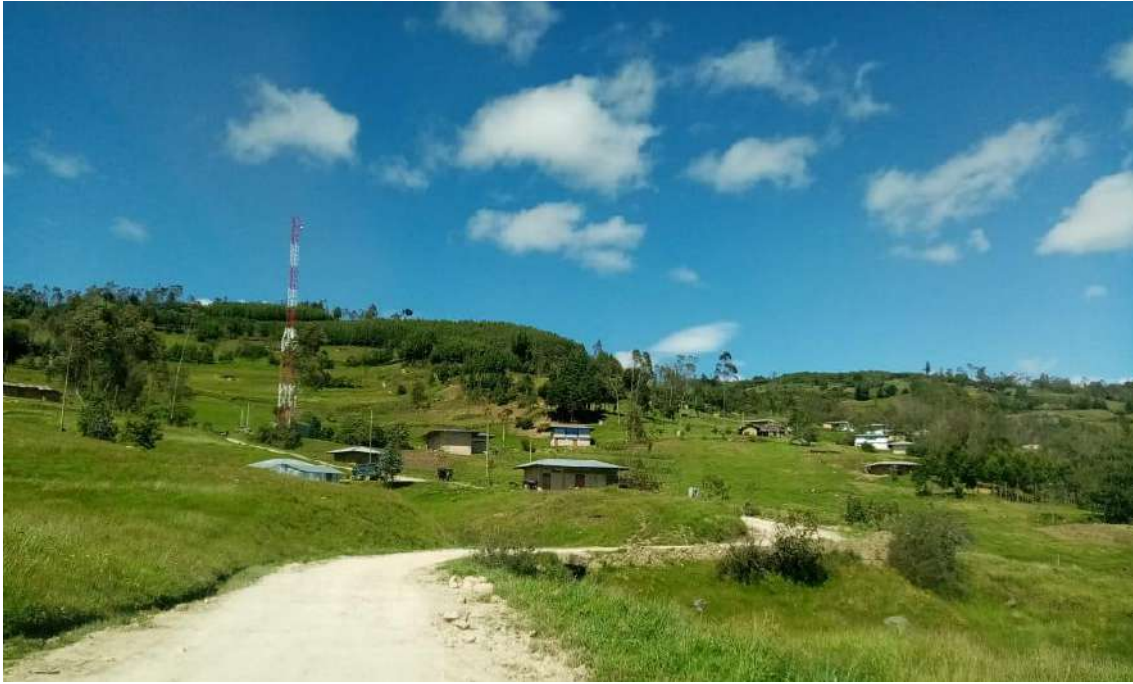
Figura 5: Estado de las viviendas.
