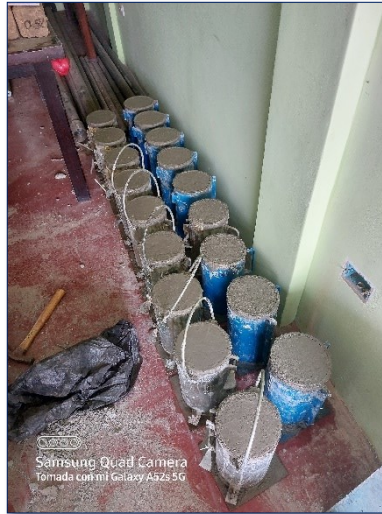
Figura 14. Preparación de concreto 210kg/cm 2 - probetas cilíndricas
