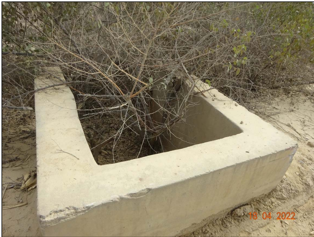
Foto N° 10: Alcantarilla existente en malas condiciones, presentando problemas de colmatación, Agrietamiento, y vegetación.
