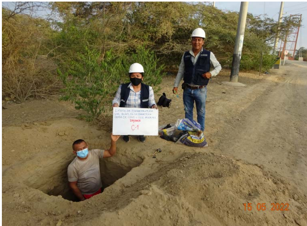
Foto N° 01: Calicata 01 – km 0+000 – CASERIO PAMPA DE LINO
