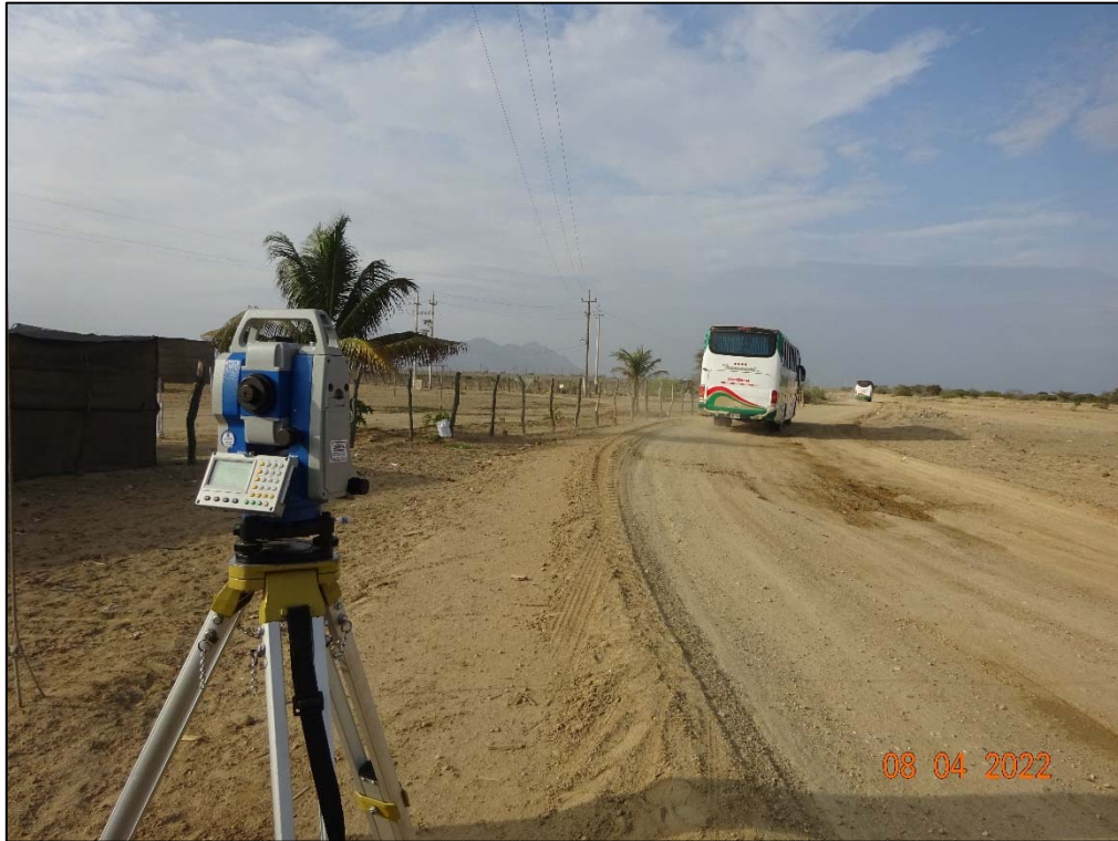
Foto N° 3: Levantamiento topográfico – Seccionamiento cada 20m en Tangente y 10m en curvas.
