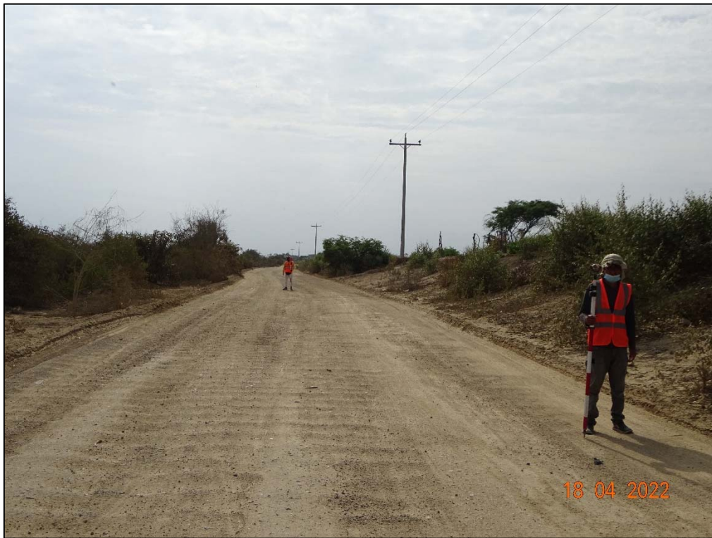
Foto N° 5: Levantamiento topográfico – Seccionamiento cada 20m en Tangente y 10m en curvas – vista del Tránsito Pesado.
