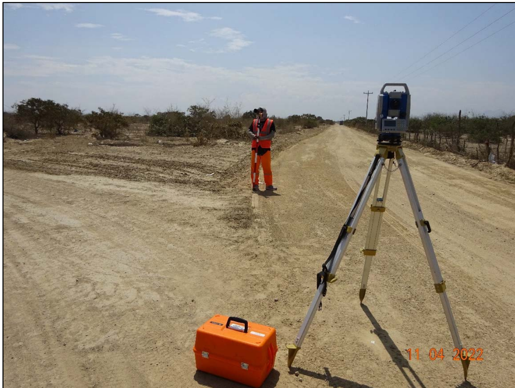
Foto N° 8: Levantamiento topográfico – Seccionamiento cada 20m en Tangente y 10m en curvas.
