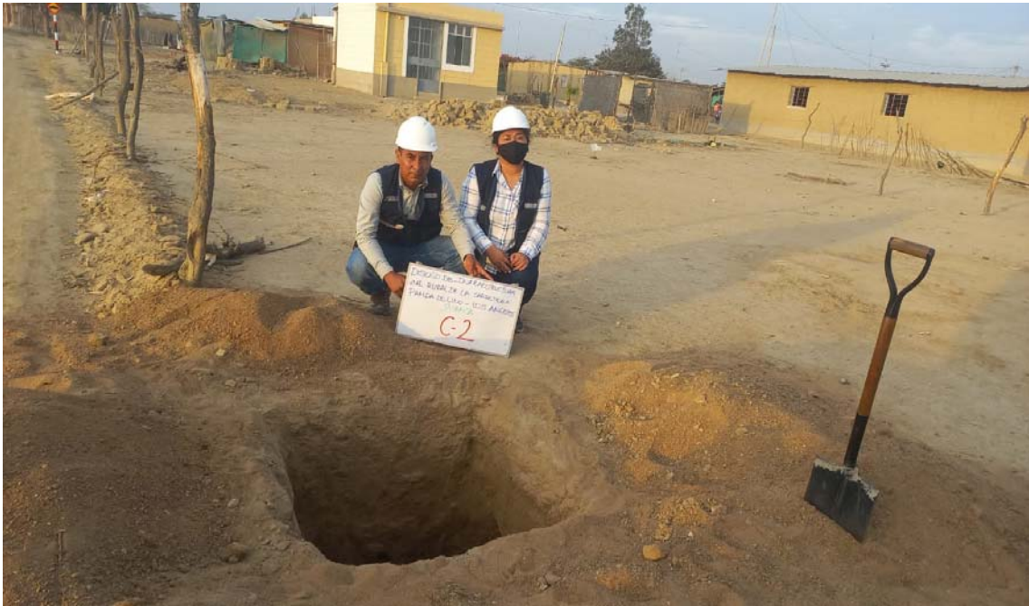
Foto N° 03: Calicata 02 – km 1+000, Prof: 1.50m
