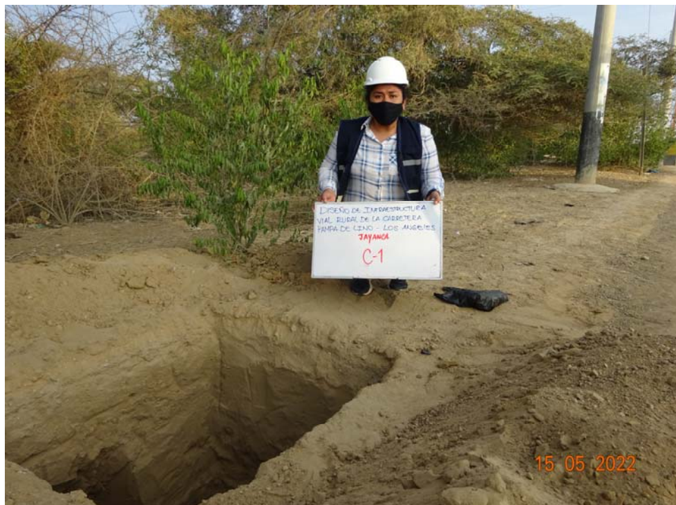
Foto N° 02: Calicata 01 – km 0+000, Prof: 1.50m
