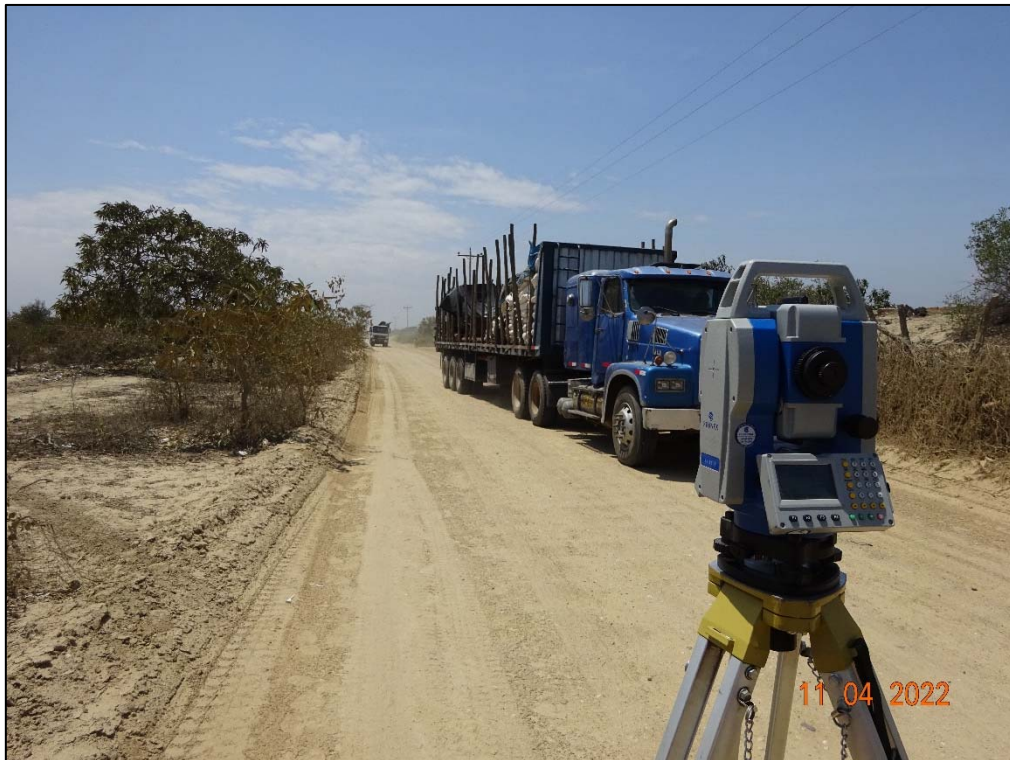
Foto N° 4: Levantamiento topográfico – Seccionamiento cada 20m en Tangente y 10m en curvas – vista del Tránsito Pesado.
