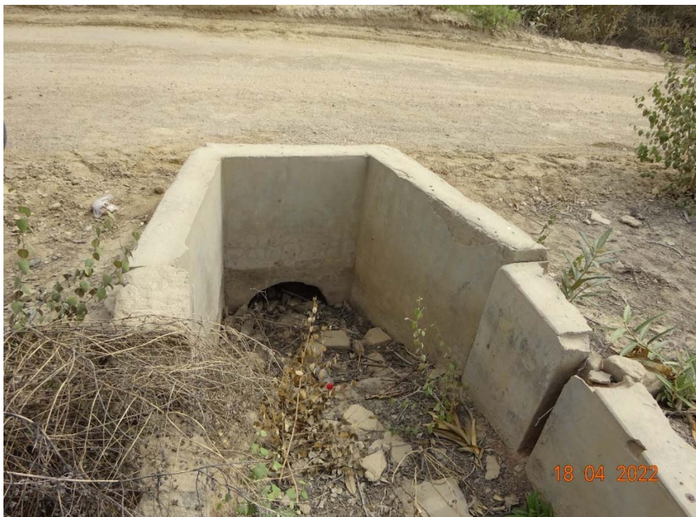
Foto N° 05: Obras de Arte (alcantarilla) en mal estado.
