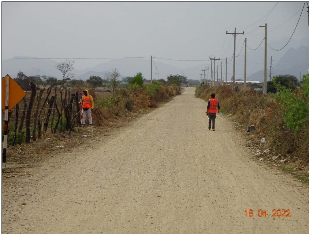
Foto N° 7: Levantamiento topográfico – Seccionamiento cada 20m en Tangente y 10m en curvas – vista del Tránsito Pesado
