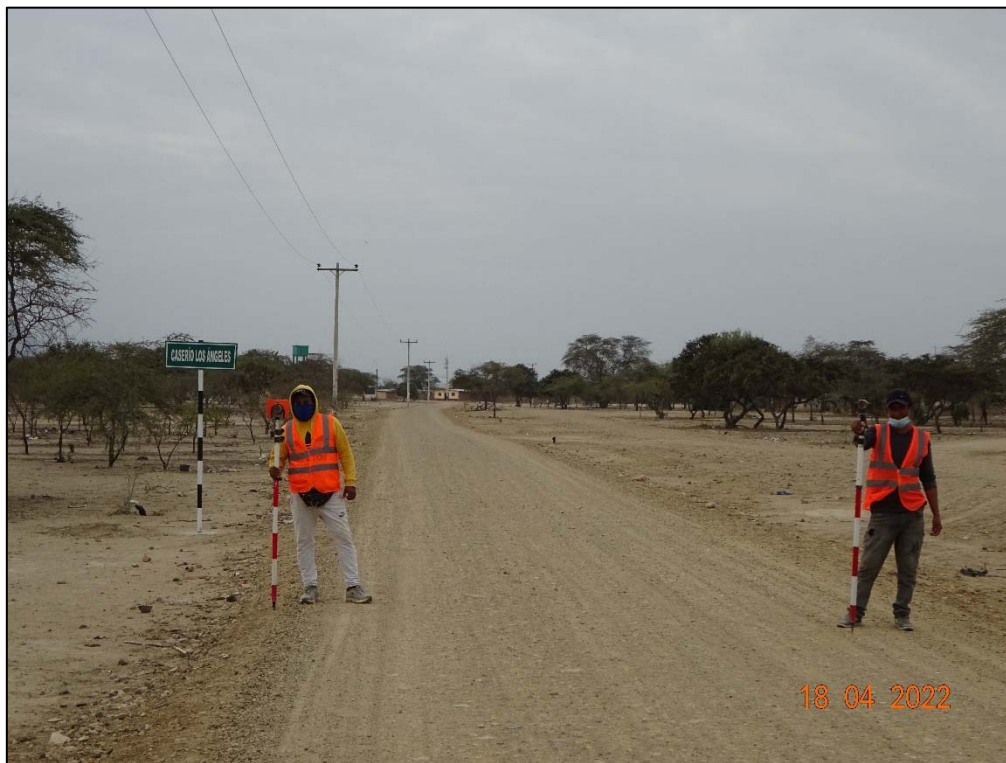
Foto N° 13: Levantamiento topográfico – Seccionamiento cada 20m en Tangente y 10m en curvas.
