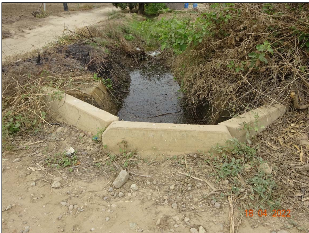
Foto N° 10: Alcantarilla existente en malas condiciones, presentando problemas de colmatación, Agrietamiento, y vegetación.
