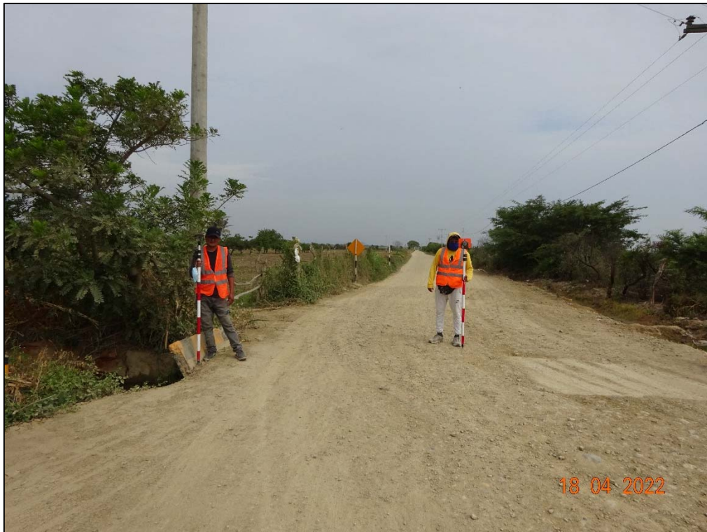
Foto N° 6: Levantamiento topográfico – Ubicación de Obras de arte existentes: Alcantarillas.
