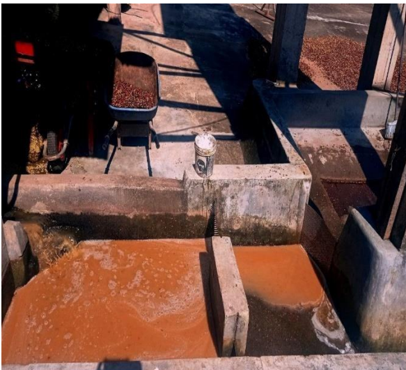
Pozo del punto de toma de muestra
