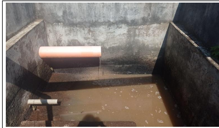
Figura 8. Pozo de almacenamiento de aguas mieles filtradas provenientes del beneficio húmedo del café.
