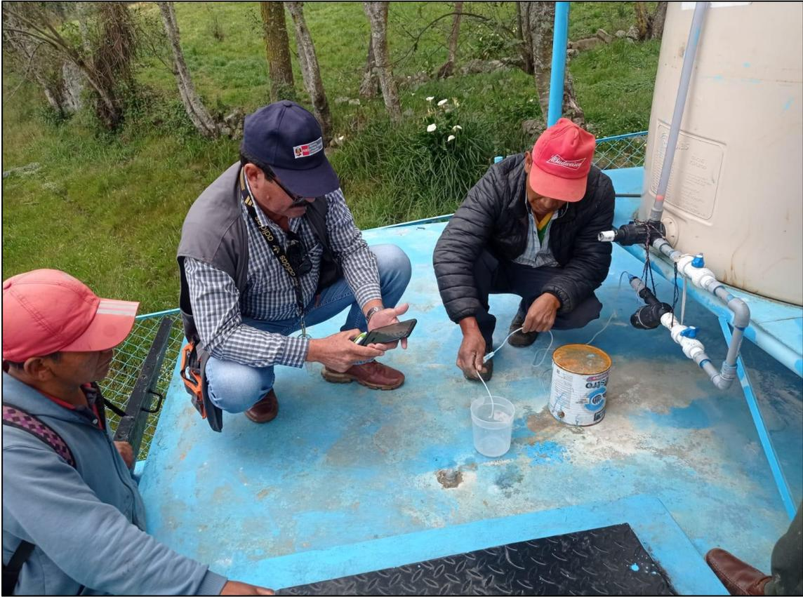
**Calibración del Sistema de Cloración Instalado en el Caserío Nueva Esperanza.**
