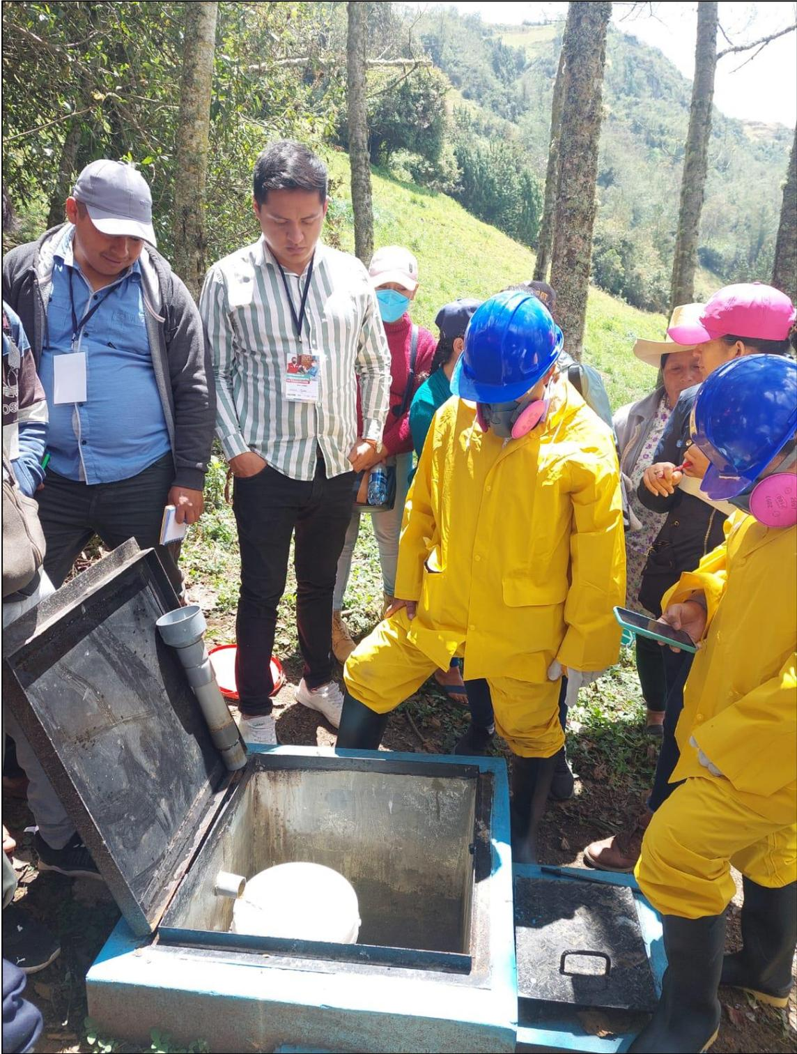
**En la Captación de Agua del Caserío Nueva Esperanza Realizando el Aforo del agua para calibrar el sistema.**
