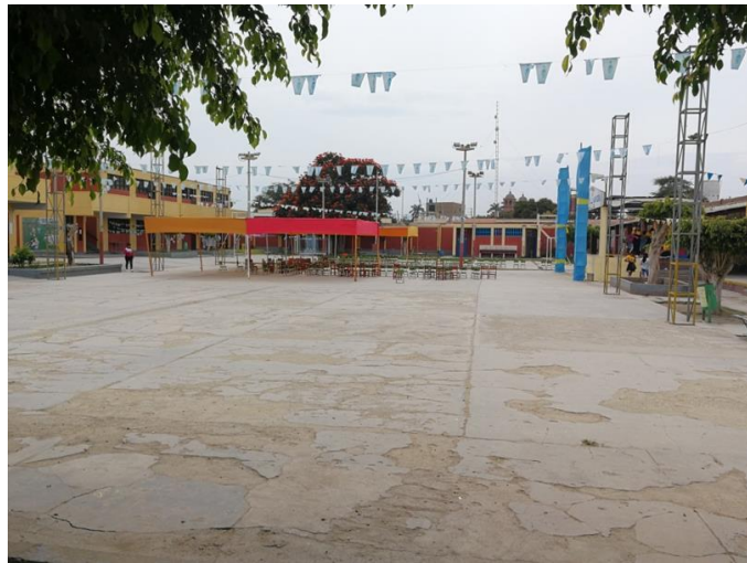
Imagen 09: Estado actual – Patio Central
