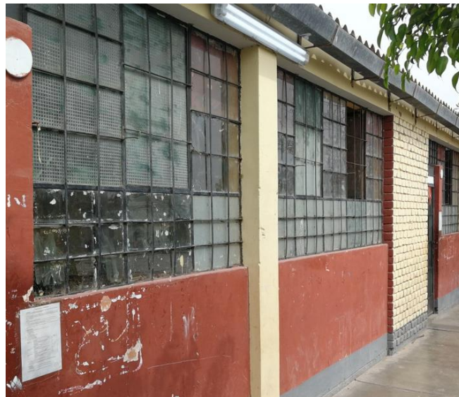
Imagen 08: Estado actual – Bloque Administrativo Fuente: Inspección en campo
