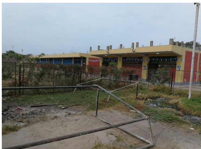
Imagen 01: Estado actual de I.E. María de Lourdes 01
