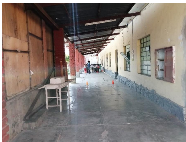
Imagen 02: Estado actual de I.E. María de Lourdes 02
