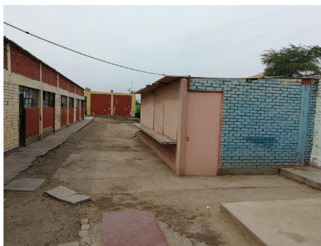
Imagen 03: Estado actual de I.E. María de Lourdes 03
