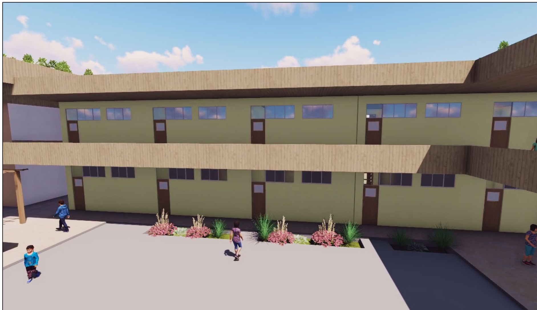
Vista de Pabellón N°01 Nivel Primario.
