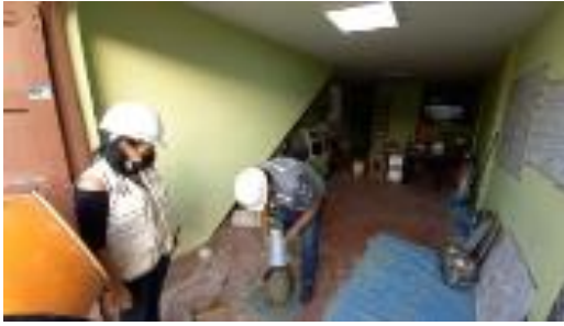
Anexo 19.3. retiramos el cono de abrams de la mezcla de concreto.
