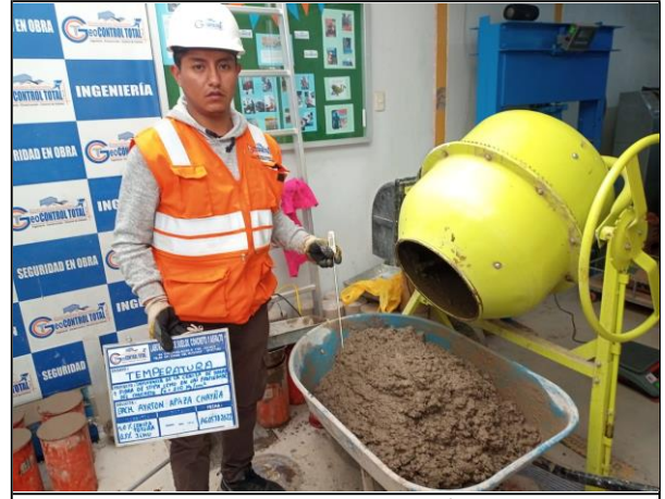
EVIDENCIA FOTOGRAFICA N° 32. DESCRIPCION: Ensayo de temperatura en el concreto. 2022
