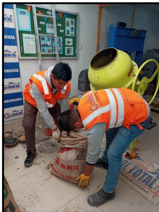
Figura 15. Preparación del concreto cumpliendo el diseño
