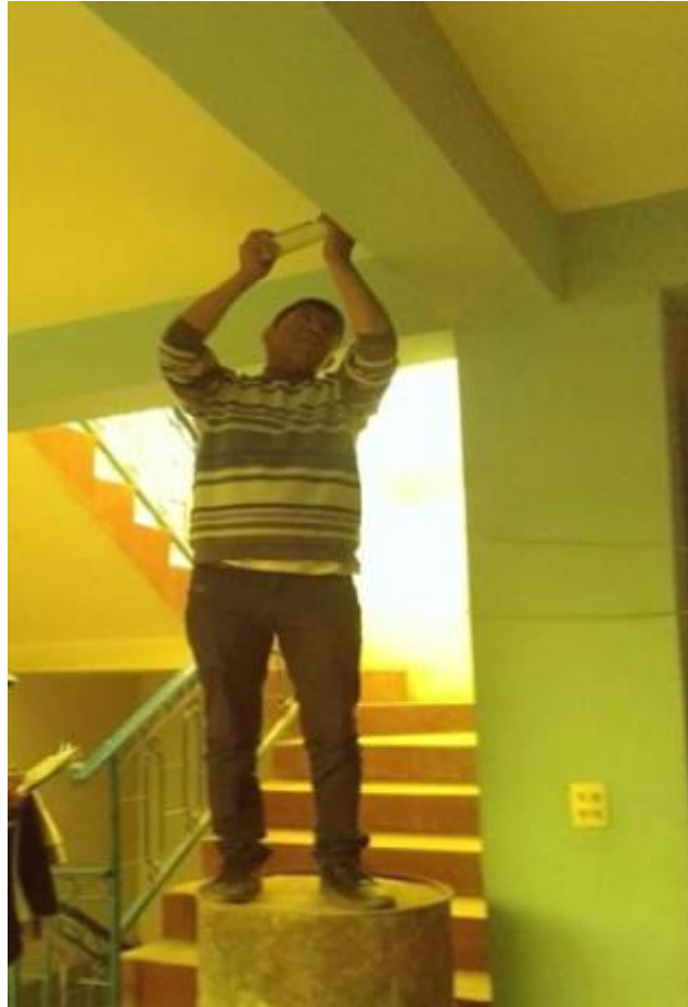
FOTO N°6: ENSAYO DE ESCLEROMETRÍA.
