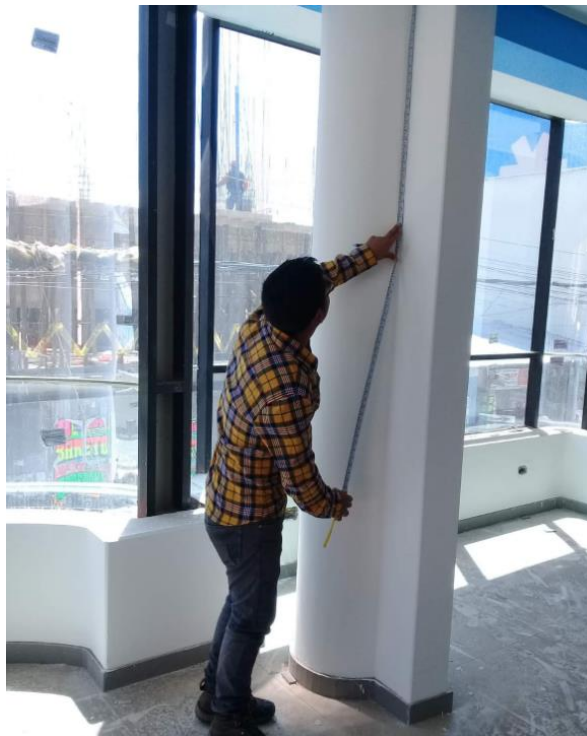
FOTON°4: MEDICIÓN DE LOS ELEMENTOS ESTRUCTURALES.
