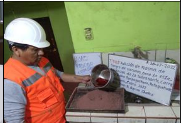
Fig.18.- Amasando suelo con dosificación.
