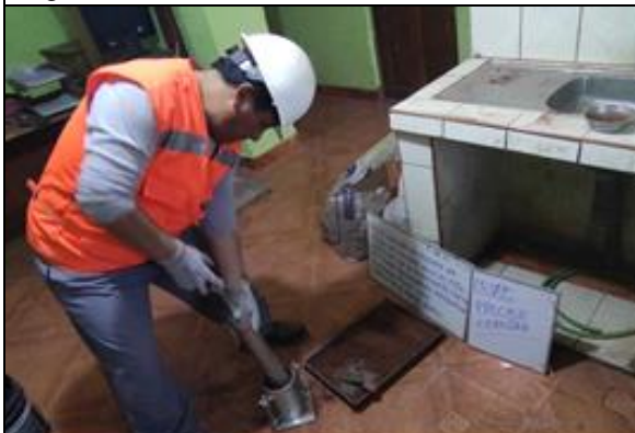
Fig. 19.- Compactando en 3 capas a 25 golpes
