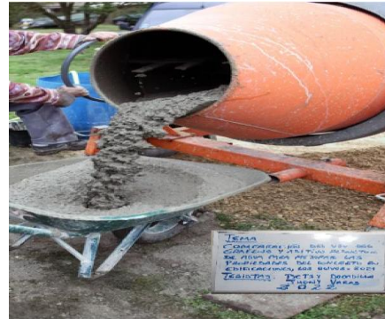
Figura 12: Preparación de la mezcla de concreto
