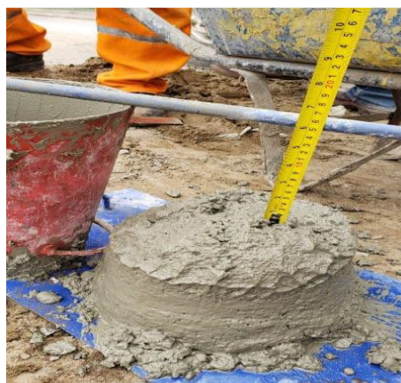
Figura 15: Medición del asentamiento
