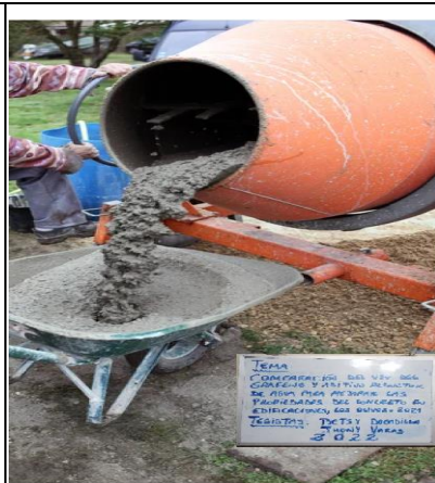
Foto 11: Preparación de la mezcla de concreto
