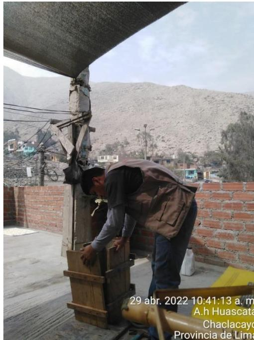
Figura 29. Armado del segundo encofrado.
