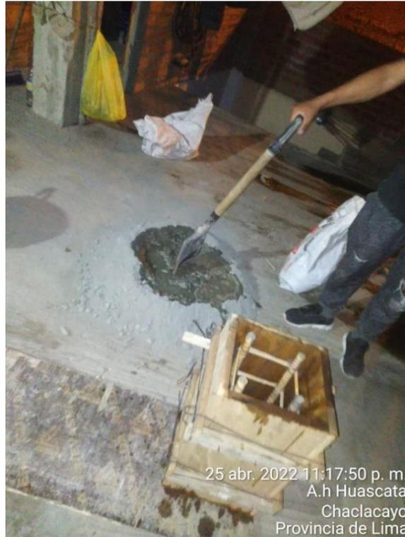
*Figura 27.* Mezclado del Concreto.
