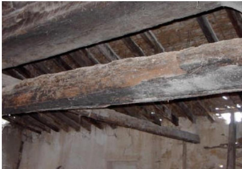
*Figura 6.* Estructura de madera y caña después de ser sometido a fuego
