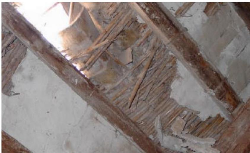
*Figura 7.* Techo de cubierta de cañas, descompuesta por hongos y bacterias.
