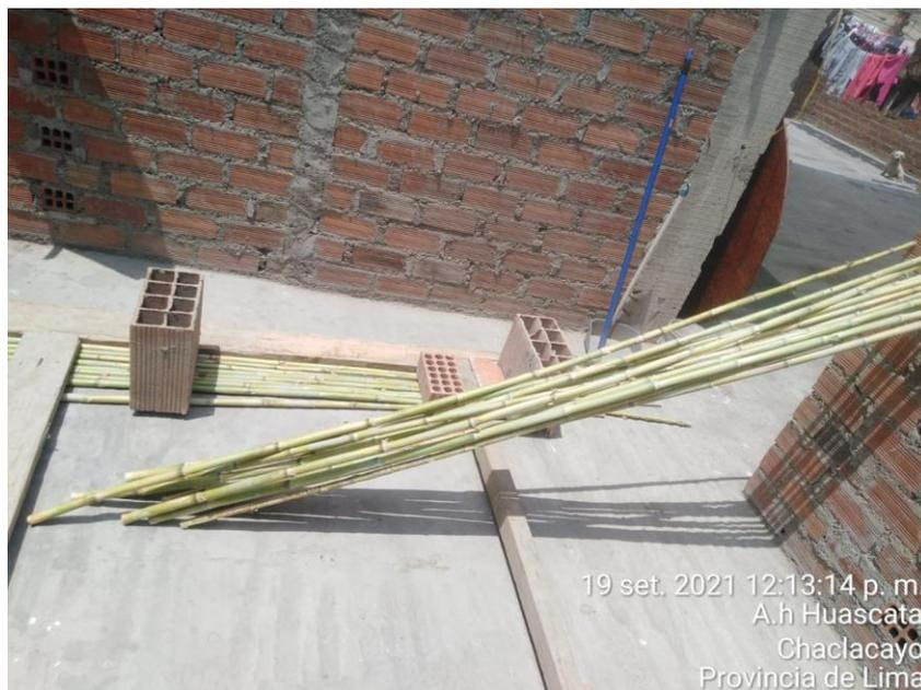
*Figura 12.* Proceso de secado de la caña.
