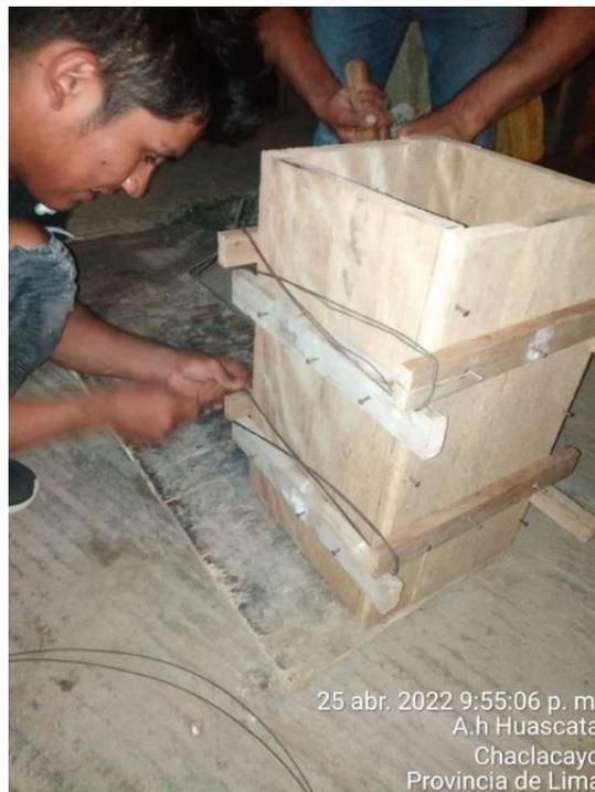
Figura 25. Armado del Encofrado.
