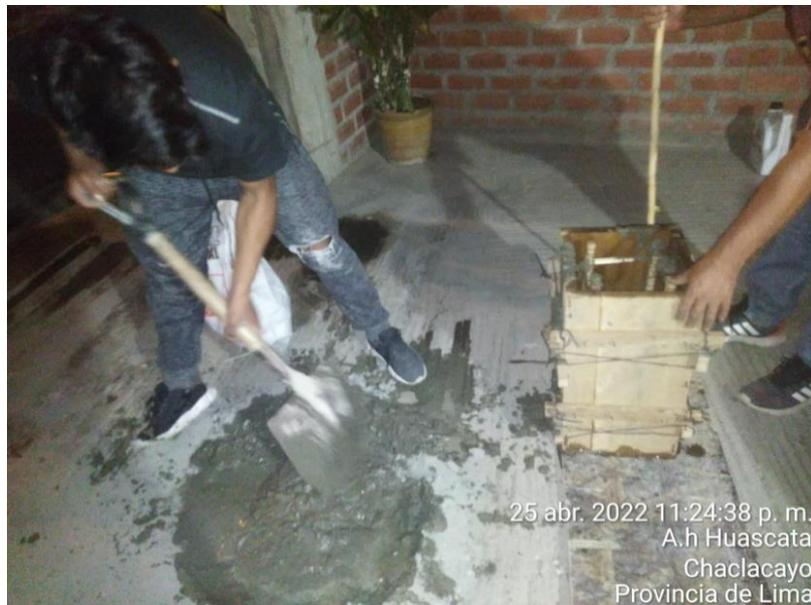
*Figura 28.* Vaciado del Concreto.
