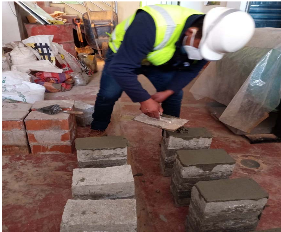
Fotografía 44. “Refrentado de las pilas de ladrillos de concreto”
