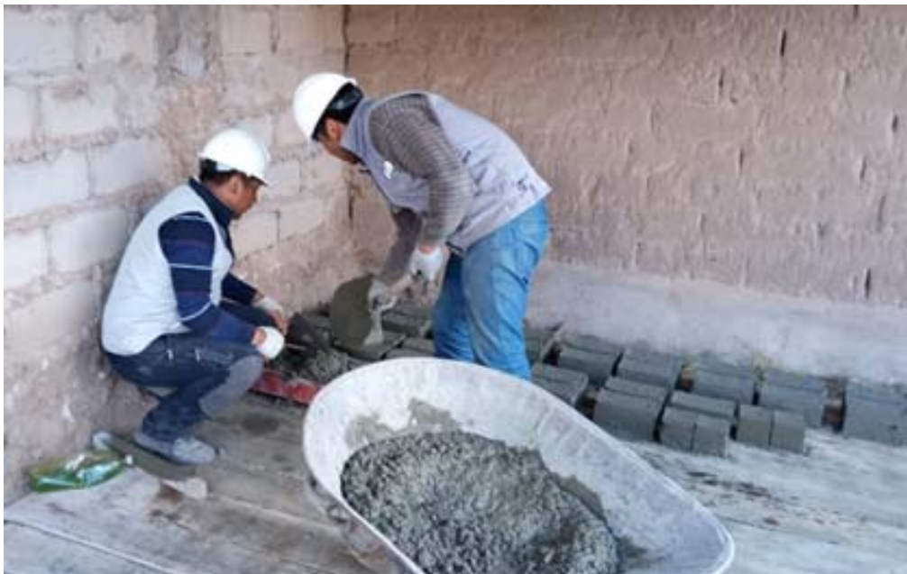
Fotografía 26. “Elaboración de ladrillos de concreto”
