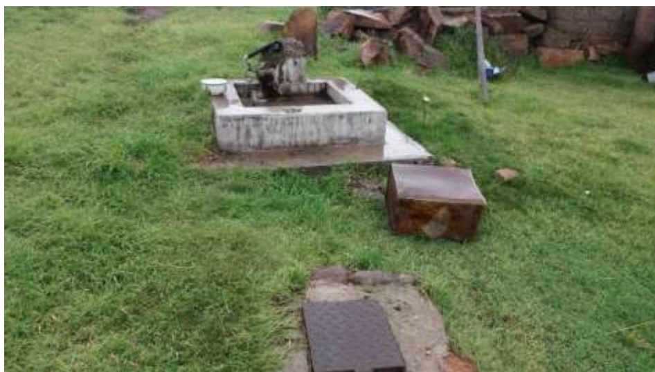
Fotografía N° 2. Cámaras de válvulas existentes.
