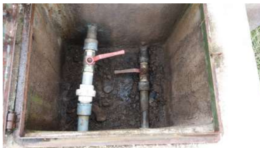
Fotografía N° 4. Cámaras de válvulas existentes.
