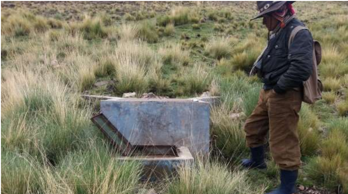
Fotografía N° 1. Captación de agua existente.
