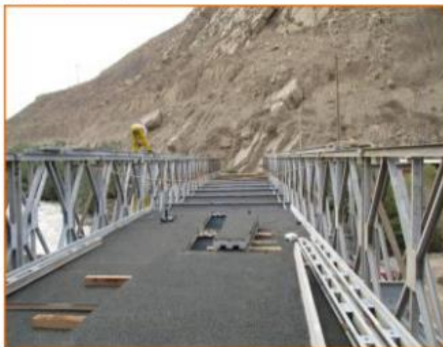
Inicio de obra
