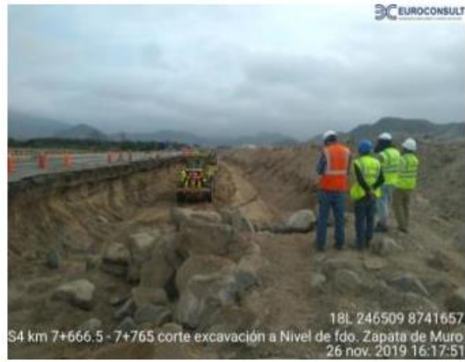
Figura 17. Inicio de Obra Proyecto 140526 Fuente: Portal de Transparencia MTC
