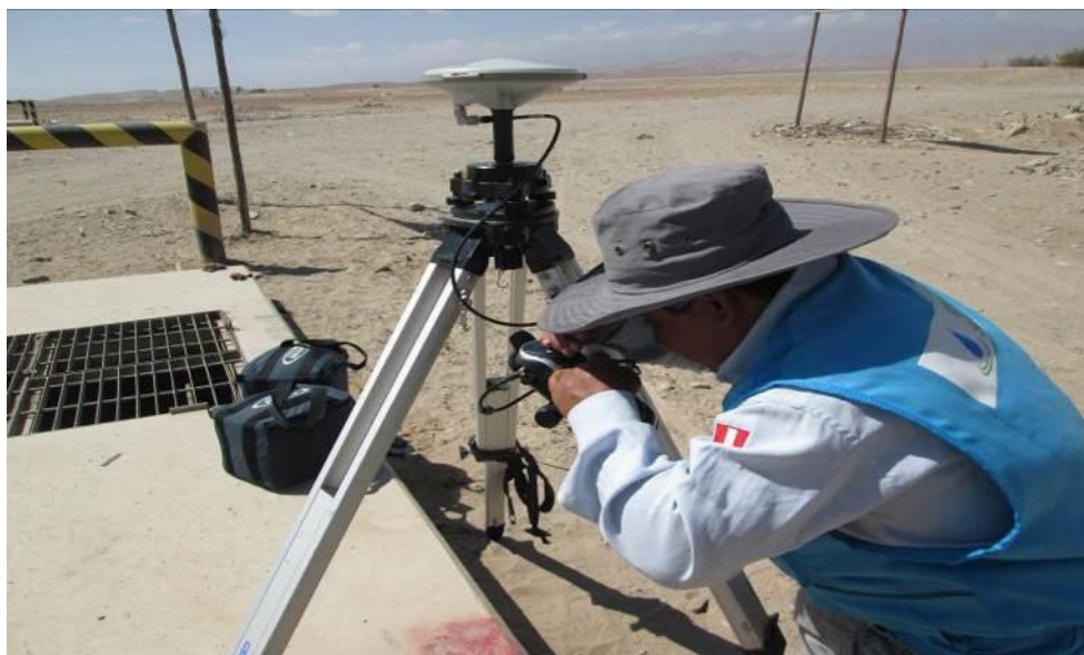
Foto N° 02: Trabajos Geodesicos en la Localidad E-5
