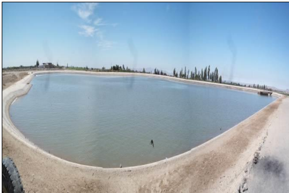
Foto N° 01: Vaso Regulador en la Localidad E-5 Majes
