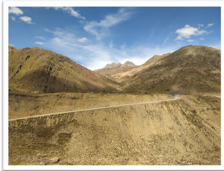
Fotografía 1: Vista Panorámica al Km 66+200 de la carretera Licapa-Lircay
