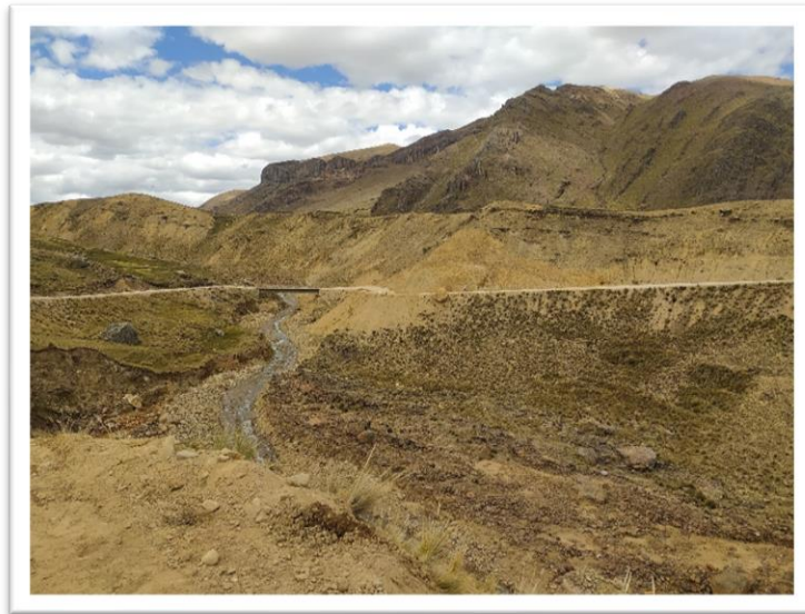
Fotografía 2: Vista Panorámica al Km 65+600 de la carretera Licapa-Lircay
