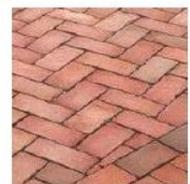
Es una piedra o bloque labrado de forma rectangular que se utiliza en la construcción de pavimentos.
