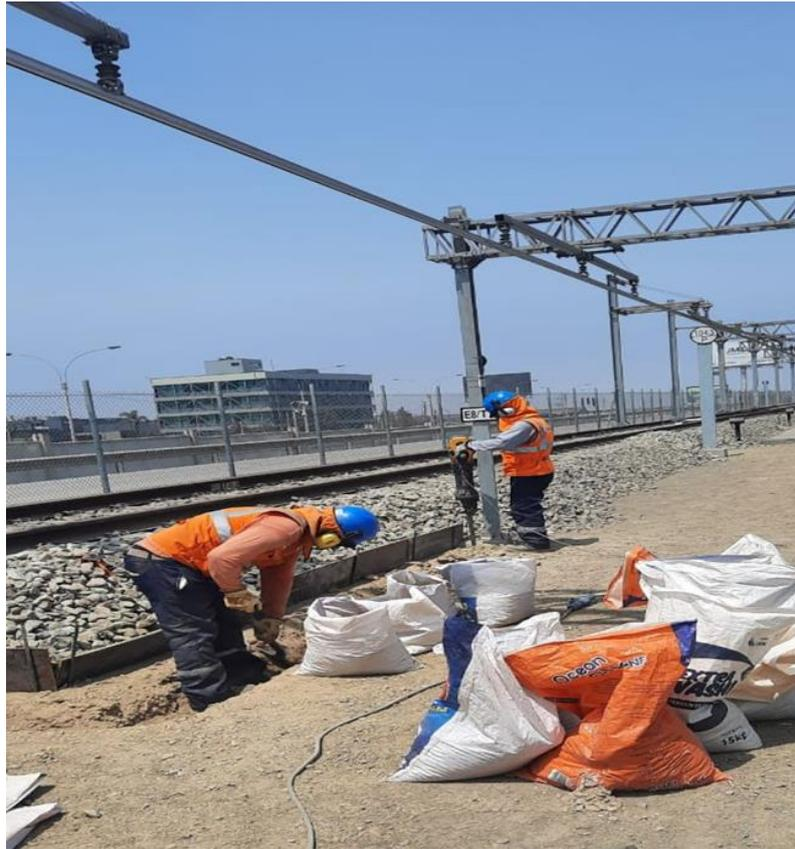
**Figura 6:** Excavación para aterramiento
