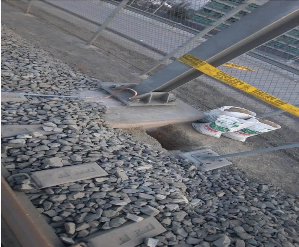
**Figura 8:** Excavación para aterramiento del poste de señalización
