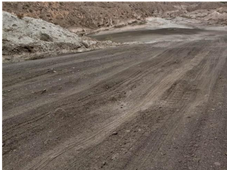
Figura 15. Ahuellamientos Progresiva 3+000
