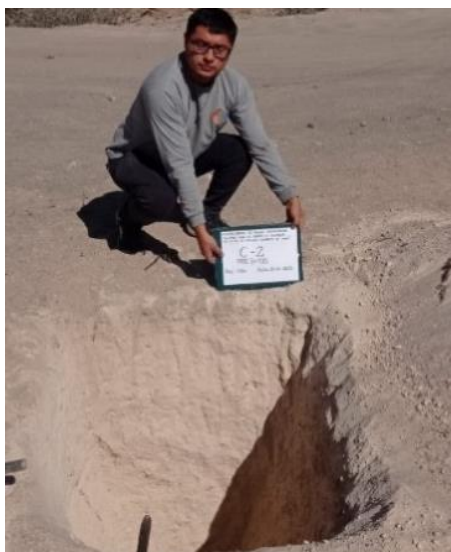
Figura 18. Calicata N°2 – 3+100 km
