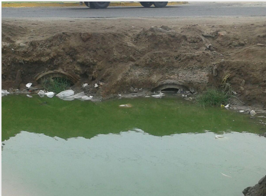
Fotografía N°10: Desfogue de desagüe de la Urbanización Las Delicias de Villa – Chorrillos.
