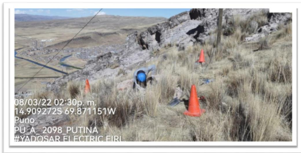
Figura 12 Excavación de Hoyos
