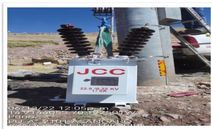
Figura 10 Montado de Trasformador
