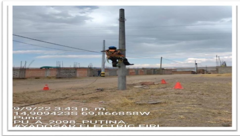
Figura 14 Puesto en Flecha del Conductor
