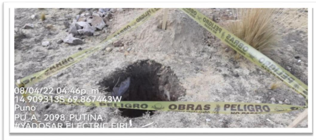
Figura 7 Excavación de Hoyos
