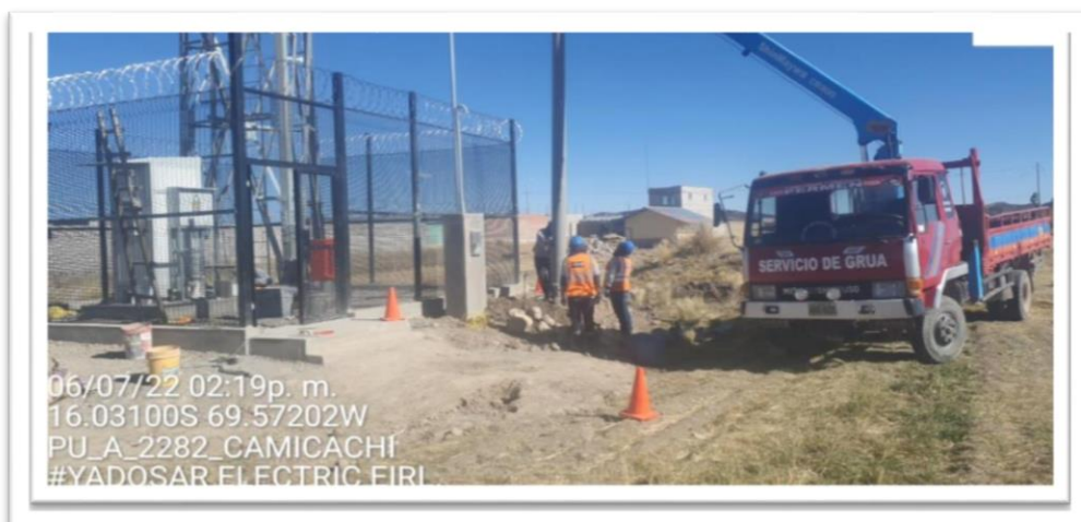
Figura 13 Izaje de Postes con Grúa
