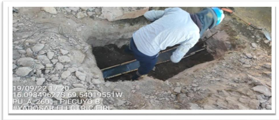
Figura 9 Tratado de Pozo a Tierra
