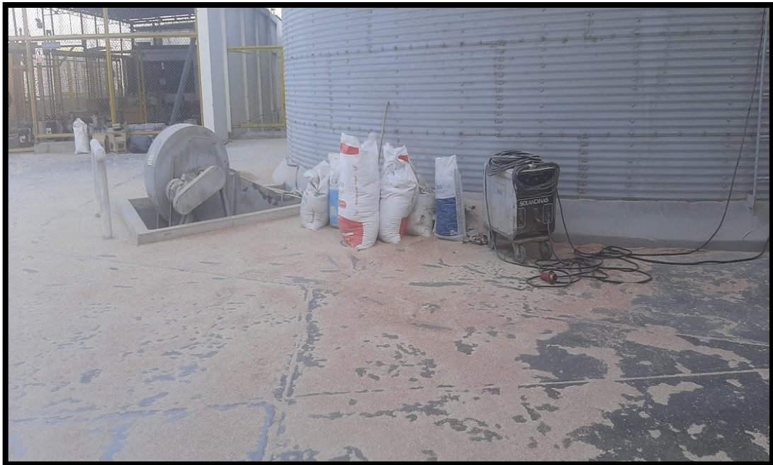
Foto 14. presencia de polvo, durante la recepción de maíz
