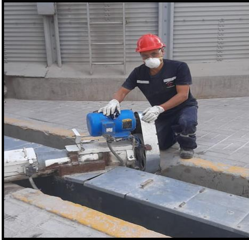
Foto 9. Limpieza de transportadores helicoidales.
