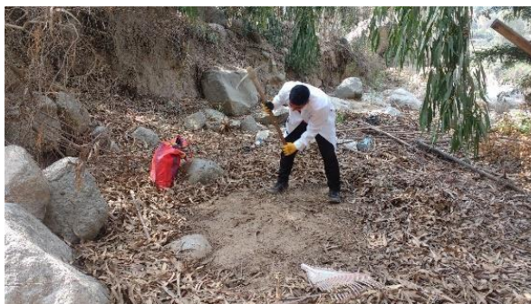
Figura 7: Realización de calicatas
