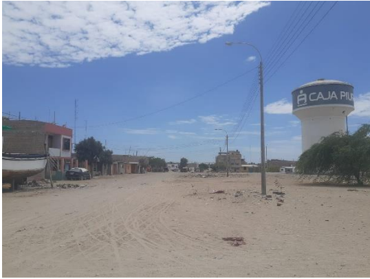
Foto 5: Tanque de agua abastece la zona
