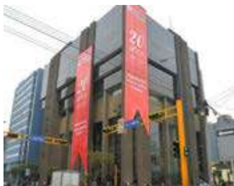
Figura 15. Fachada del Centro Emergencia Mujer – sede central.
