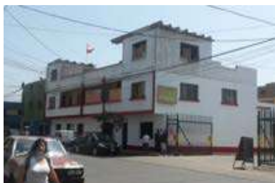
Figura 7. Fachada CEM - SMP
