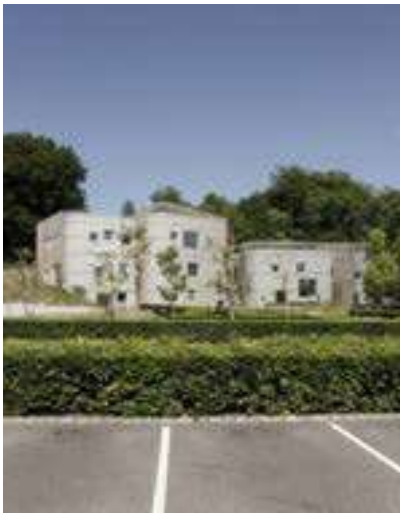
Figura 21. Fachada del Centro de Atención del Cáncer. FUENTE: (ArchDaily, Centro de Atención del Cáncer, 2013)
